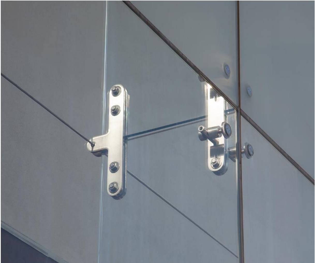
Figura 37 – Mecanismo de aço para redução de deflexões.
