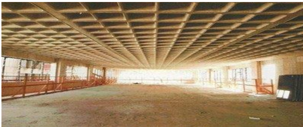
Figura 1 – Pavimento de laje nervurada
