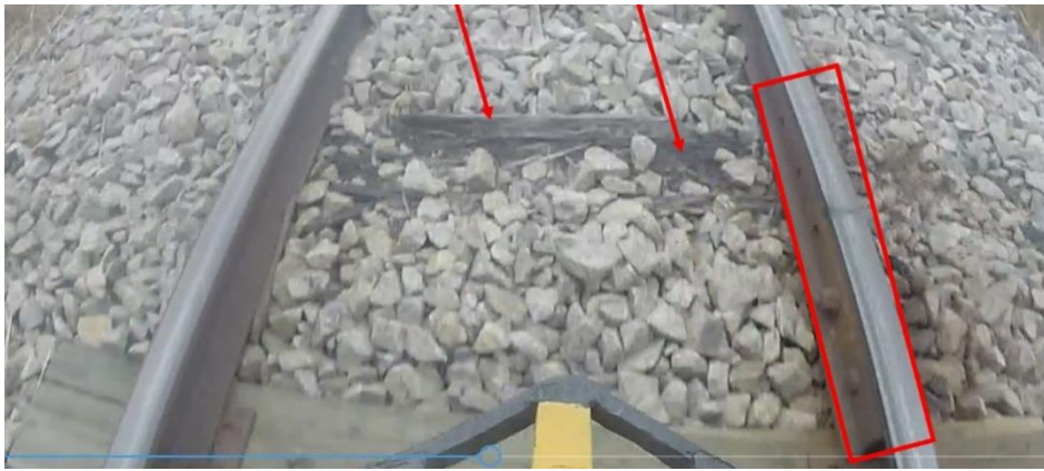
(b) Dormente ruim localizado em junta
