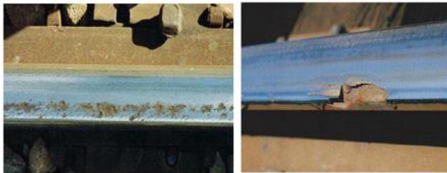
(c) Estilhaçamento do canto de bitola (d) Despedaçamento do canto de bitola
