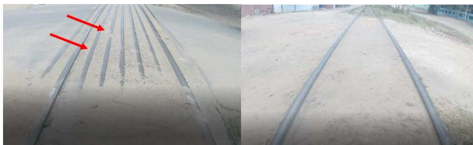
a) Passagem de Nível (PN) normal b) Passagem de Nível (PN) clandestina
