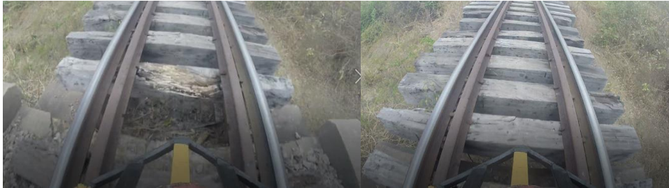
(a) Severidade 0: 1 Dormente estragado
