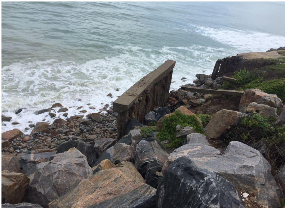
Figura 37: Pedras e muretas na tentativa de conter o avanço do mar na Praia do Pacheco.
