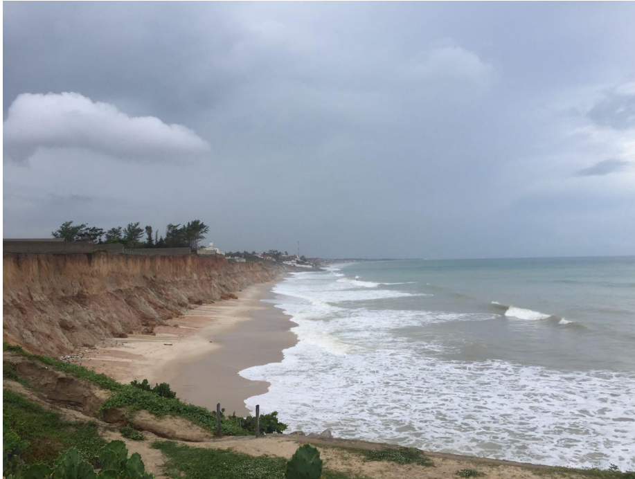
Figura 36: Processo de erosão marinha na Praia do Pacheco.
