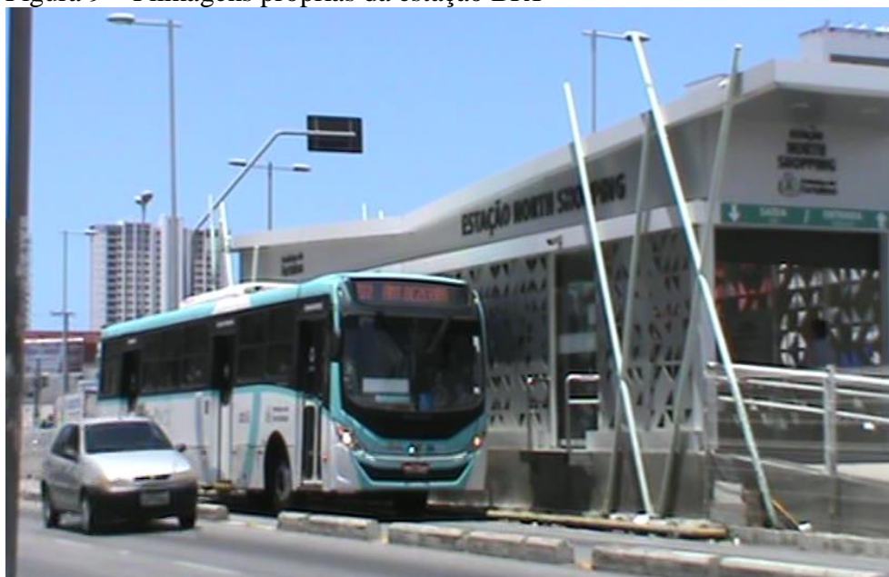
Figura 9 – Filmagens próprias da estação BRT
