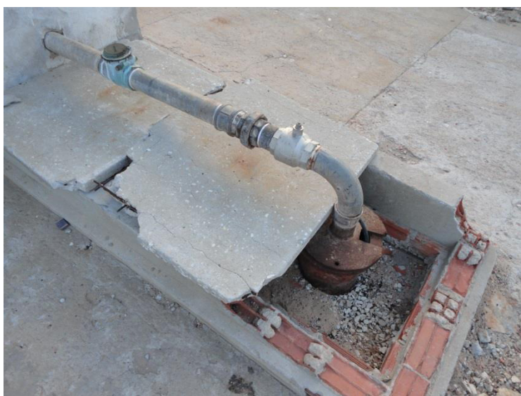
Figura 11 – Poço IS05 na estrada entre Ponta Grossa e Redonda
