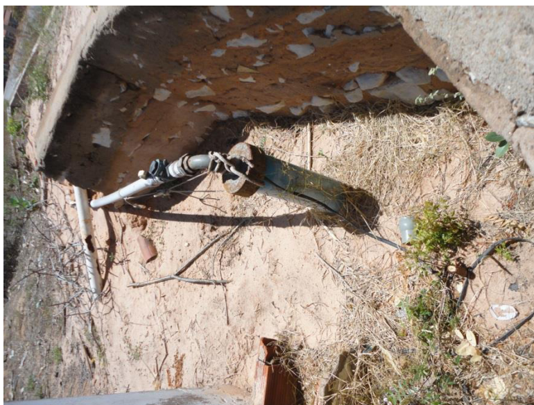
Figura 19 – Poço IS20 na comunidade de Melancias de Cima
