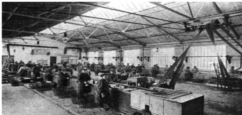
Figura 5 - Galpão de triagem de lixo, em 1900, cidade de Munique/Alemanha.
