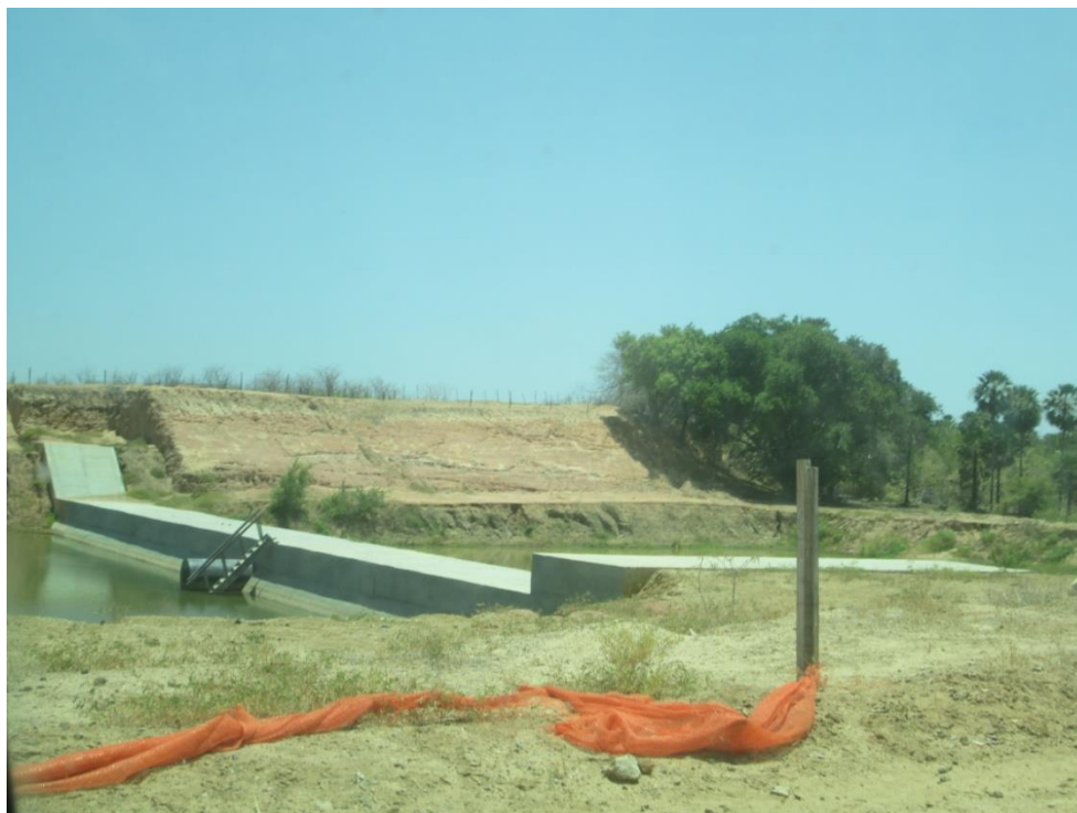
Figura 24 - Obras destinadas ao barramento do Rio Apodi para a construção do Perímetro Irrigado de Santa Cruz.
