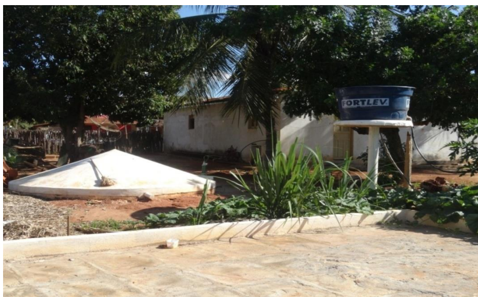
Figura 11 - Cisternas de placa e cisternas-calçadão, tecnologias de armazenamento da água e convivência com o semiárido localizadas nos quintais produtivos do Assentamento Milagres (região da Chapada - Apodi).
