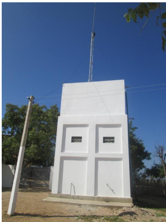
Figura 62 - Sistema de Abastecimento Comunitário de Bamburrall (Região do Vale do Apodi).
