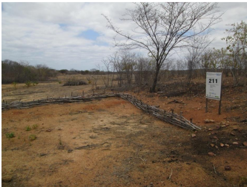
Figura 48 - Barragem subterrânea localizada na Comunidade de Arção (Região da Pedra - Apodi).
