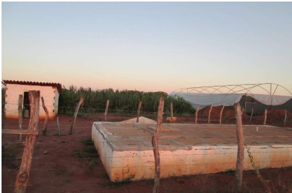
Figura 12 - Sistema de saneamento básico comunitário do Assentamento Milagres (região da Chapada - Apodi).
