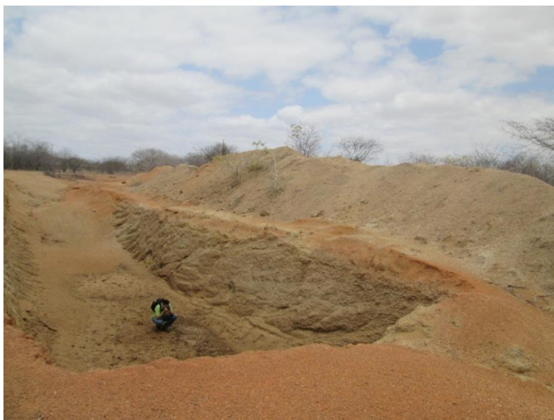
Figura 46 - Barreiro trincheira localizado na Comunidade de Arção (Região da Pedra - Apodi).
