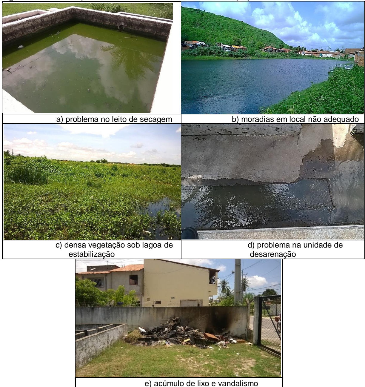
Figura 19 – Parte dos problemas verificados durante visitas da etapa preliminar
