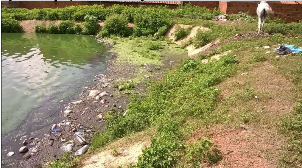
Figura 44 – Vegetação no talude das lagoas
