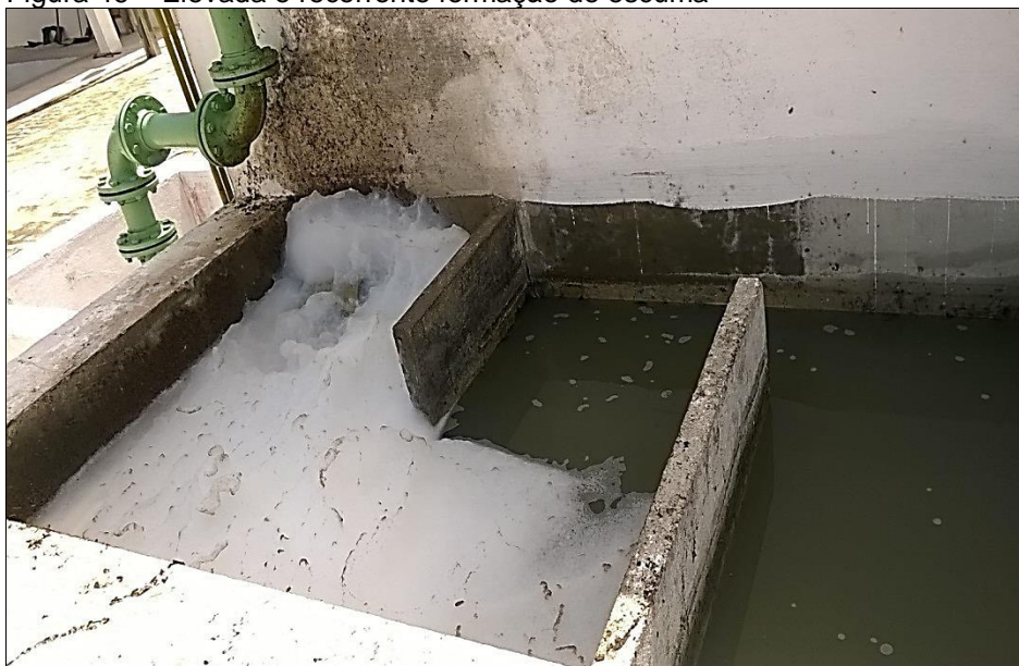
Figura 46 – Elevada e recorrente formação de espuma
