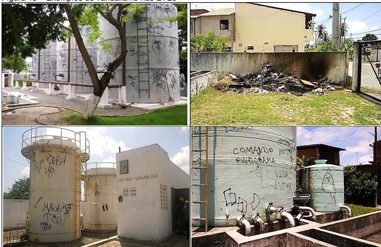
Figura 48 – Exemplos de vandalismo nas ETES
