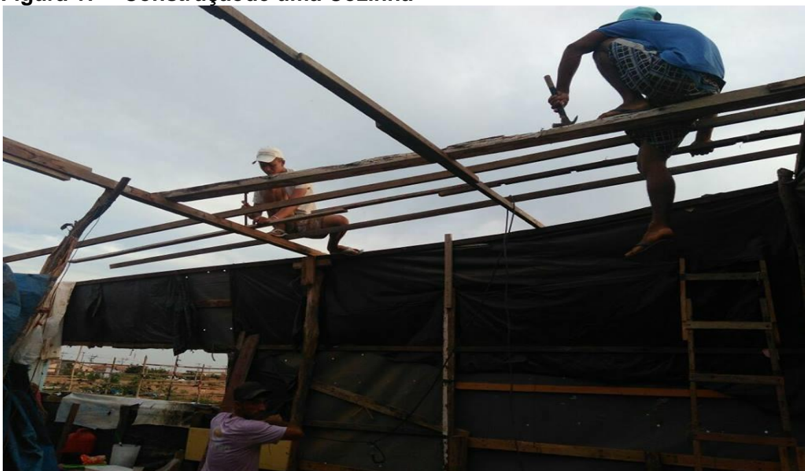
Figura 17 – Construção de uma Cozinha
