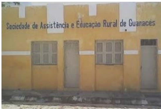
Foto 5: Sede da SAERG em Guanacés
