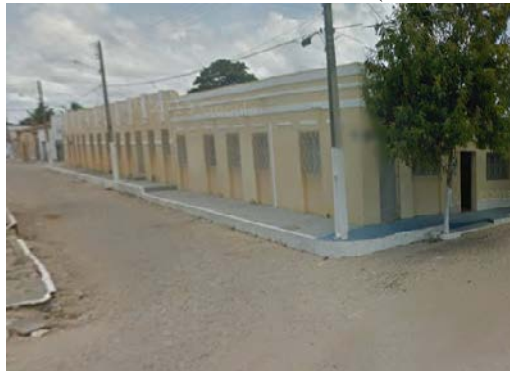
Foto 6: Lateral da sede da SARG (Prédio da banda)
