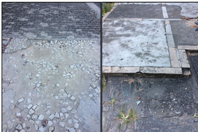
Figura 25 - Exemplos de irregularidades no piso da calçada
