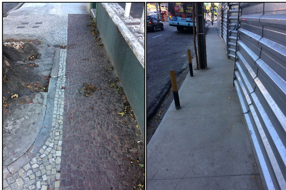
Figura 23 – Mobiliário urbano encontrado em posicionamento inadequado
