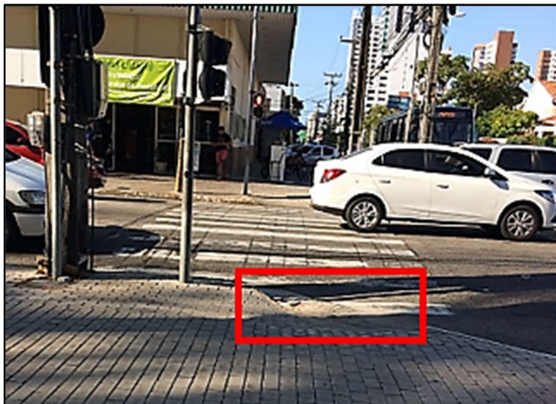
Figura 27 - Desnível encontrado em guia rebaixada
