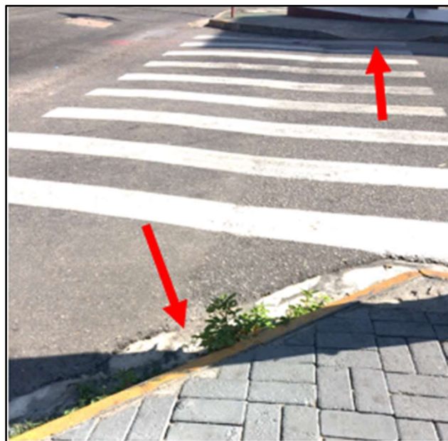
Figura 26 - Guia rebaixada em apenas um lado da rua
