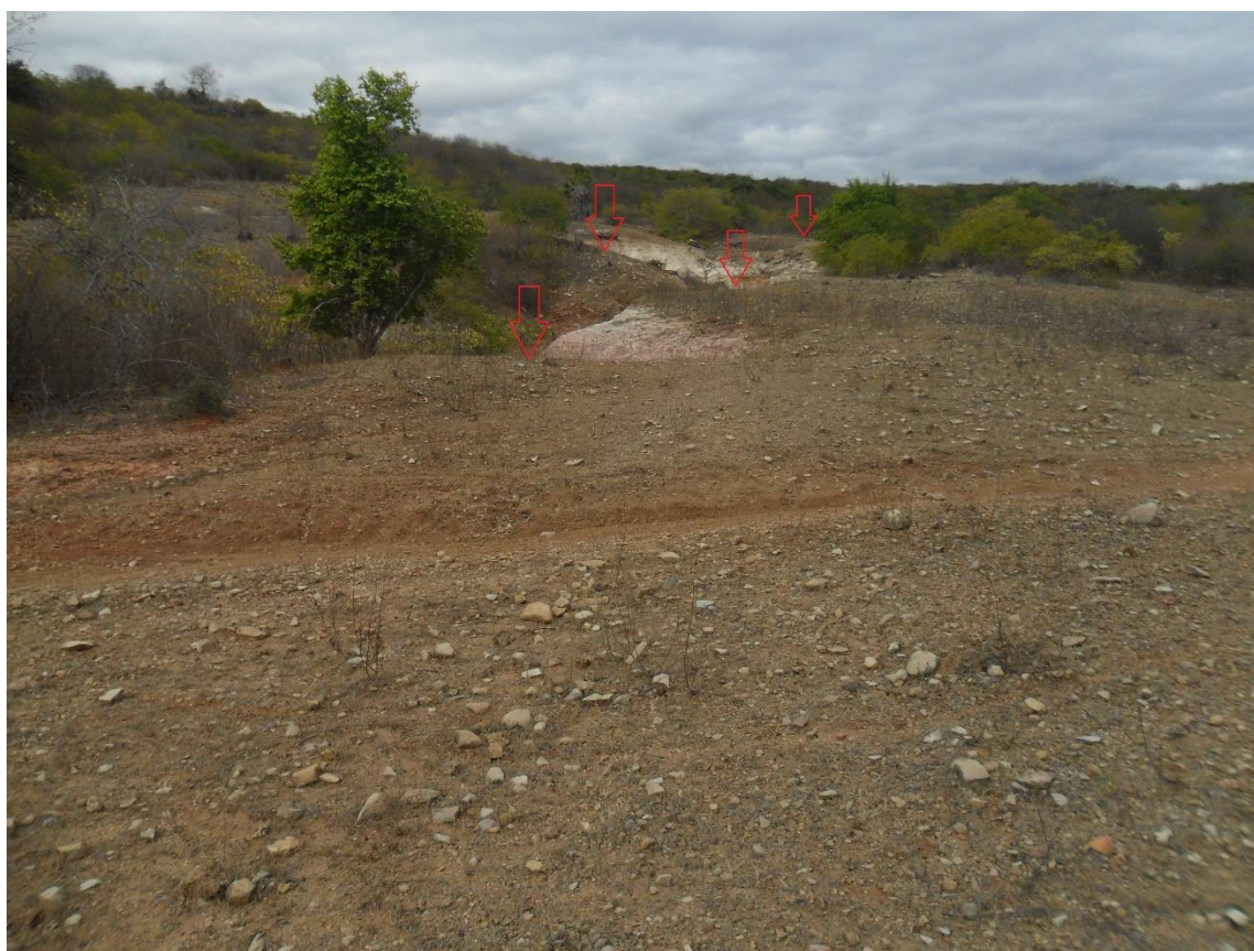
Figura 38– Processo erosivo na escarpa da Bacia Potiguar
