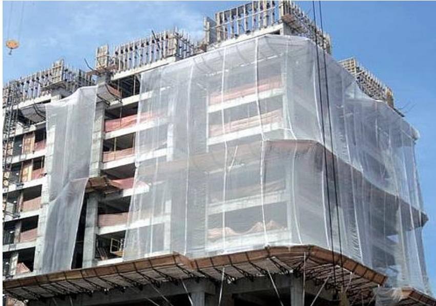
Figura 9 – Rede de proteção
