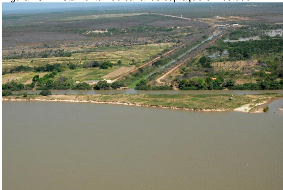
Figura 10 – Vista frontal do canal de captação em estudo.
