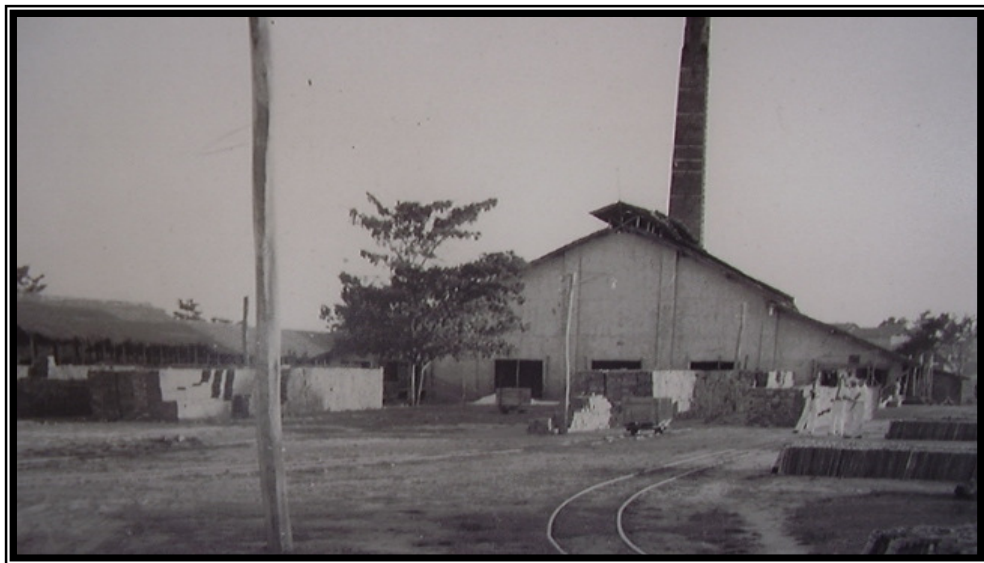
Figura 9 – Tijoleira, seção subsidiária da fábrica e os trilhos de uma pequena locomotiva para carregamento dos tijolos. Arquivo Antônio Luiz (Rio Tinto - PB).
