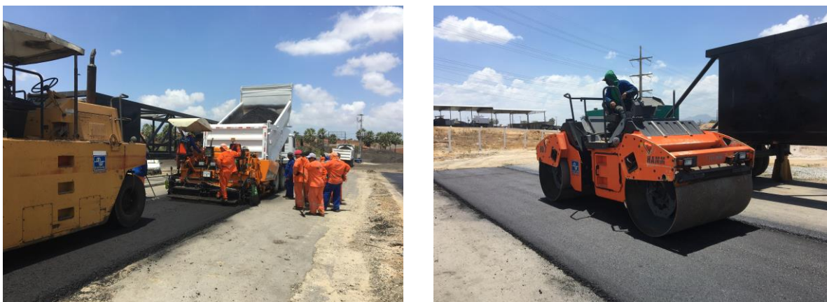
Figura 16: Execução dos trechos experimentais da Insttale Engenharia Ltda, utilizando (a) compactação com a vibroacabadora, o rolo de pneus e (b) o rolo duplo tandem.
