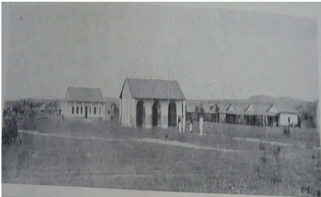
Lado direito do leprosário de Canafistula, mostrando as casas ligadas por um passadiço coberto. No centro da Praça se vêem o Cassino e ao fundo a Enfermaria. Fonte: SOUZA-ARAÚJO. 1933, Op. Cit.
