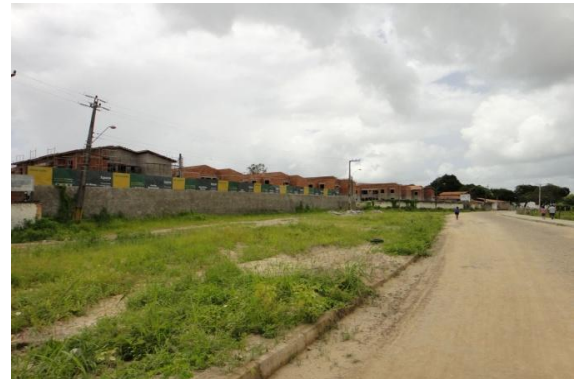
Figura 5. Foto do conjunto habitacional do bairro da Paupina
