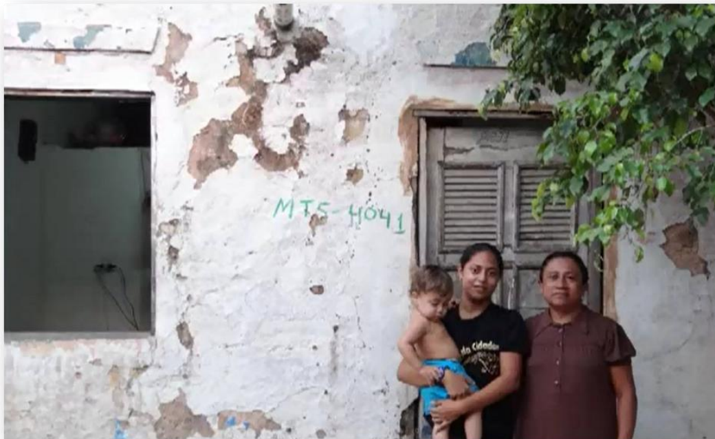
CASA MARCADA NA COMUNIDADE JOÃO XXIII
