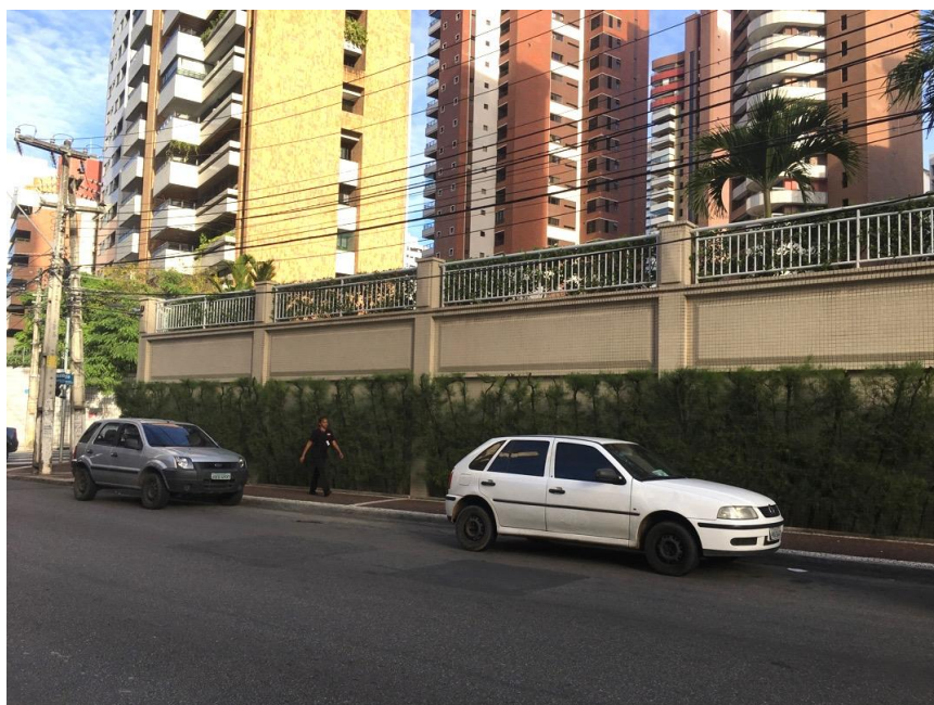
Figura 5.11 – Muro de edifício residencial multifamiliar localizado no bairro Meireles, Fortaleza-CE.
