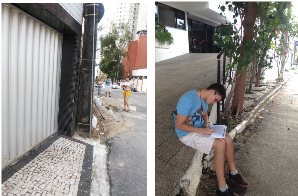
Figuras B.7 e B.8 – Imagens exemplificando a descontinuidade das calçadas.
