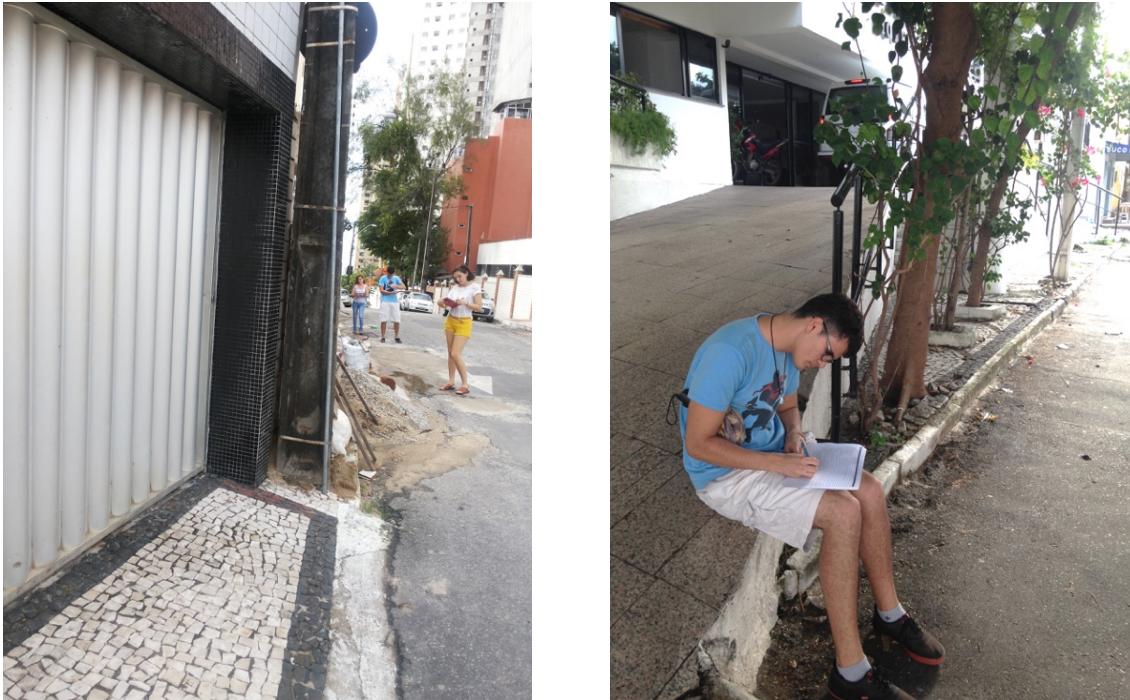
Figura 3.8 e 3.9 - Pré-teste 1 - descontinuidade e ausência de acessibilidade física das calçadas.
