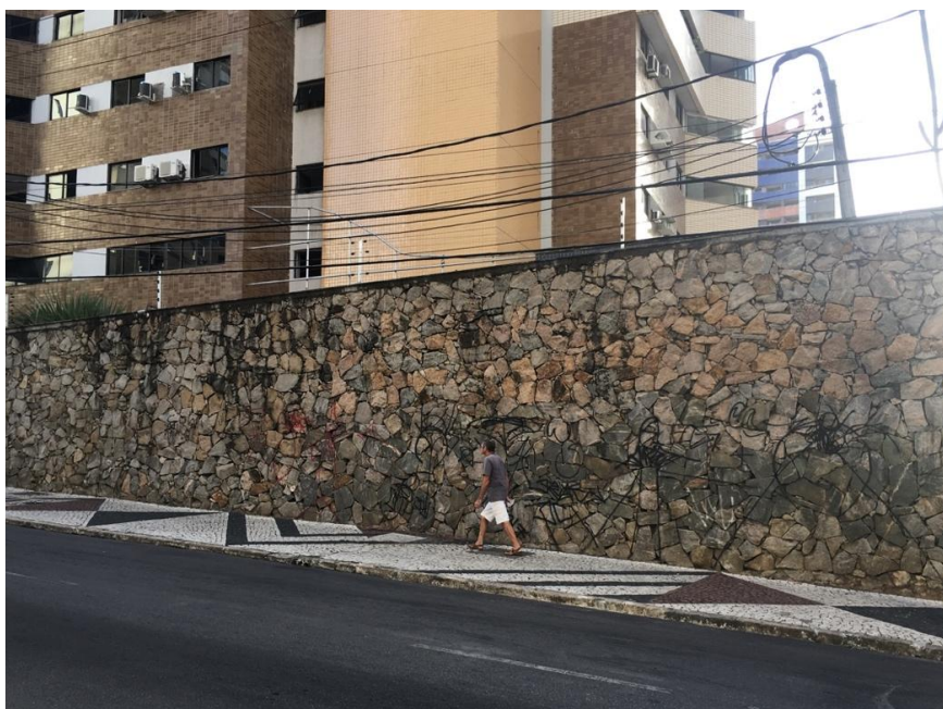
Figura 5.10 – Muro de edifício residencial multifamiliar localizado no bairro Meireles, Fortaleza-CE.
