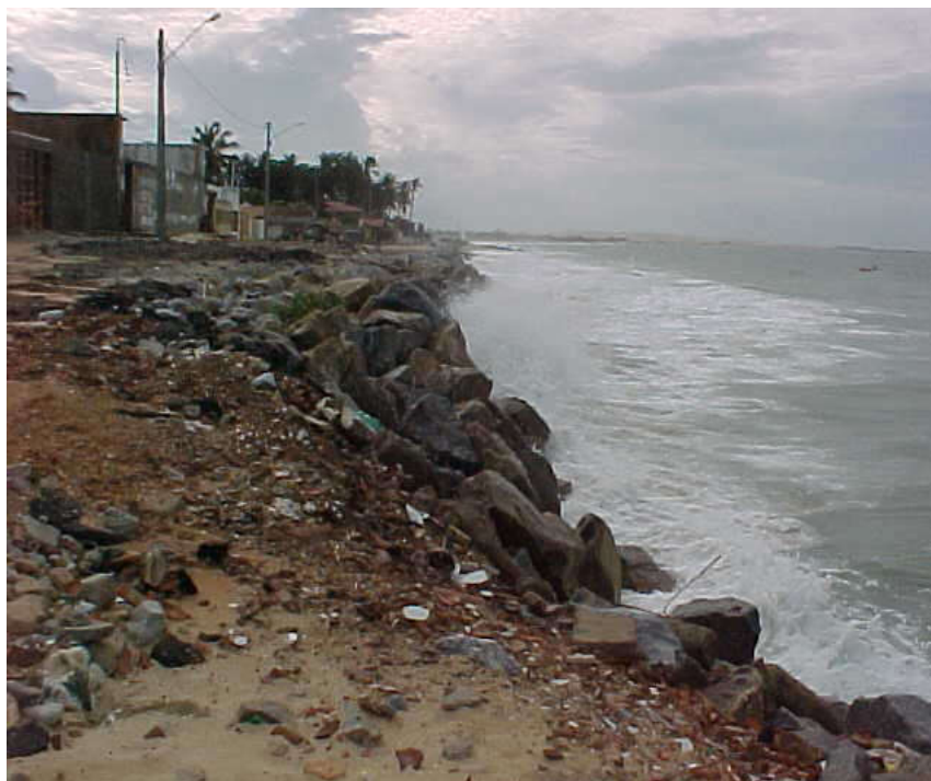
Figura 23 – Enrocamento da Praia do Pecém. ISL 1
