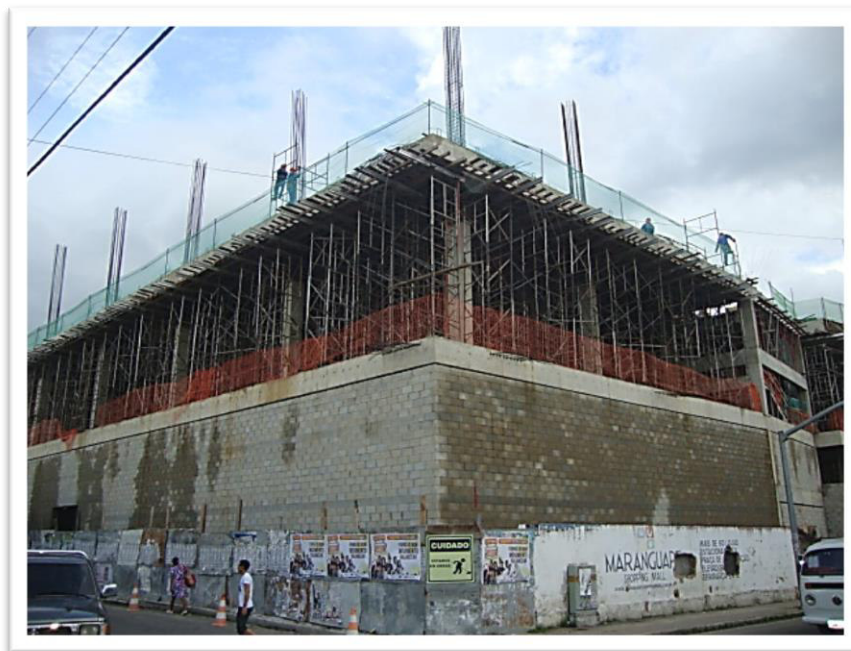
Figuras 119 - Construção do Maranguape Shopping Mall em maio de 2014
