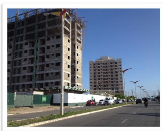
Figura 107 - Construção de prédio
