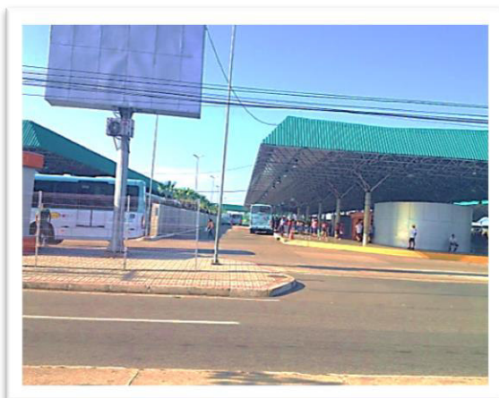
Figura 33 – Terminal de ônibus Antônio Bezerra
