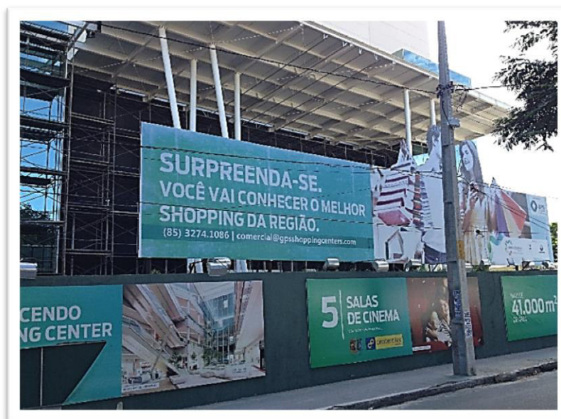
Figura 112 - Construção do Grand Shopping em março de 2016
