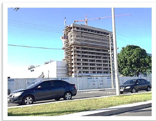
Figura 96 -Torre ao lado RioMar-Kennedy
