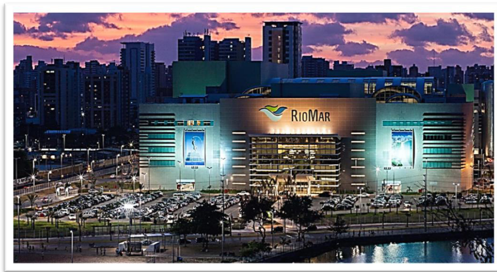
Figura 83 – Shopping RioMar-Fortaleza e verticalização no entorno
