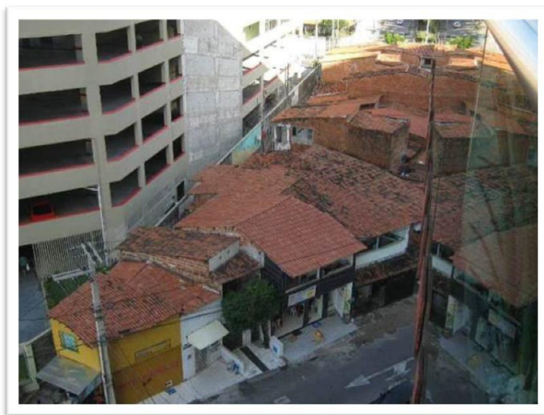
Figura 104 - Comunidade Riacho Doce e Estacionamento do Via Sul
