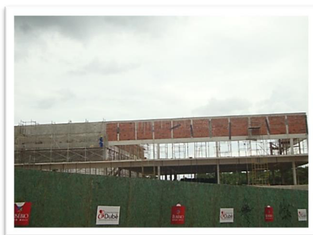
Figura 129 – Eusébio Open Mall em construção em 2014
