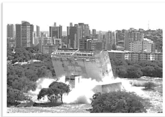
Figura 81- Implosão do antigo prédio da Brahma para a construção do RioMar-Fortaleza
