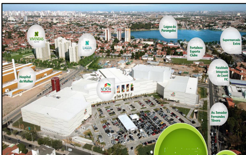
Figura 110- Destaque de equipamentos no entorno do North Shopping Jóquei
