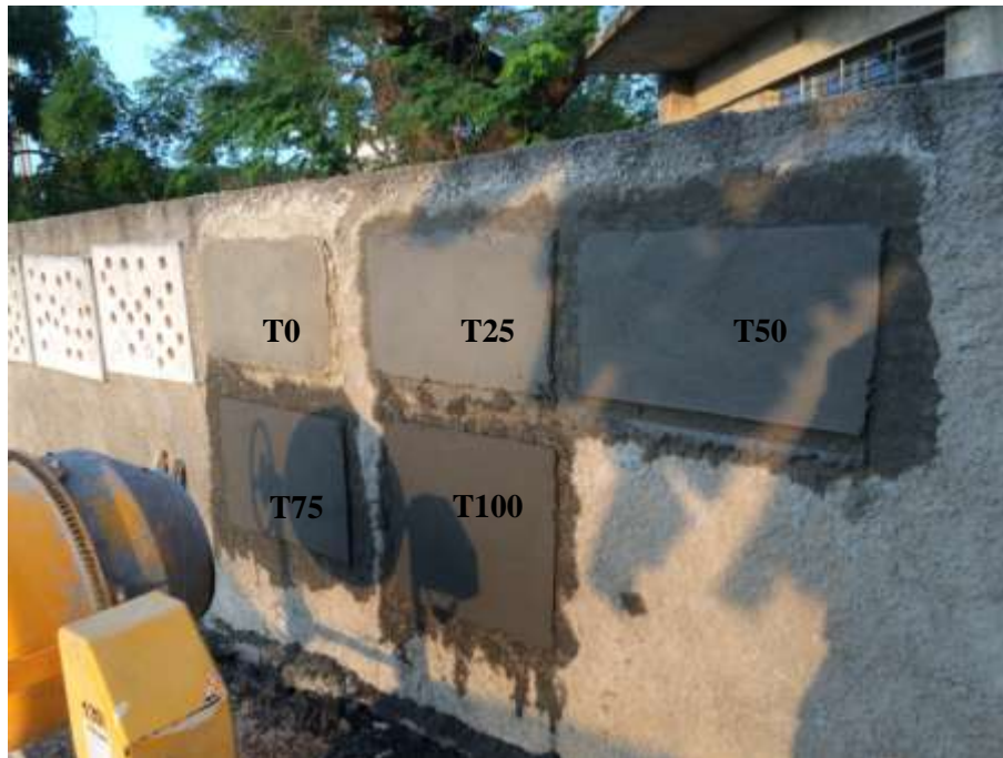
Figura 28 - Confeção dos painéis de argamassa sobre a alvenaria
