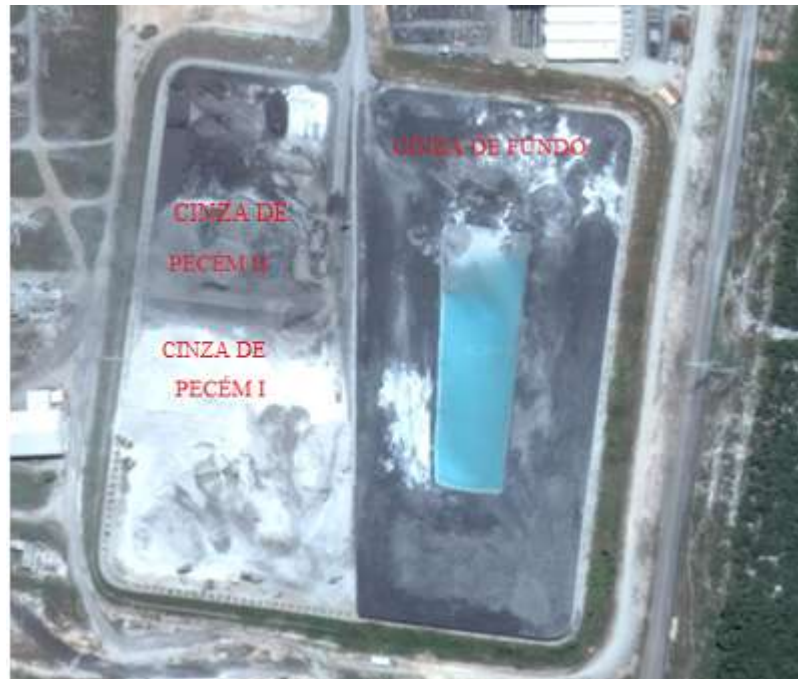
Figura 15 - Área de depósito das cinzas
