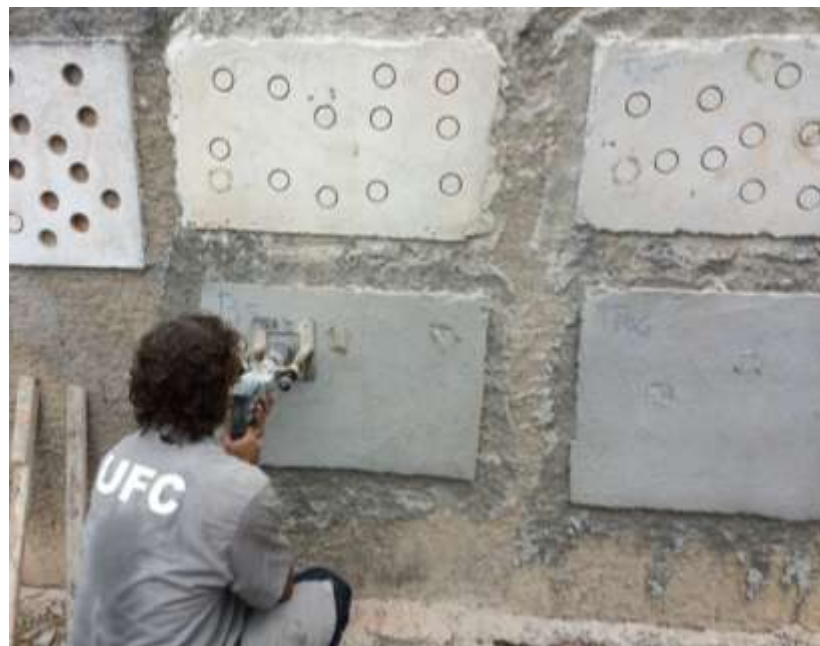
Figura 31 - Execução dos furos nos painéis
