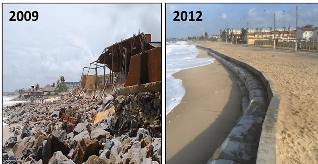
Figura 18 – Praia do Icaraí, antes e depois da implantação do Bagwall .
