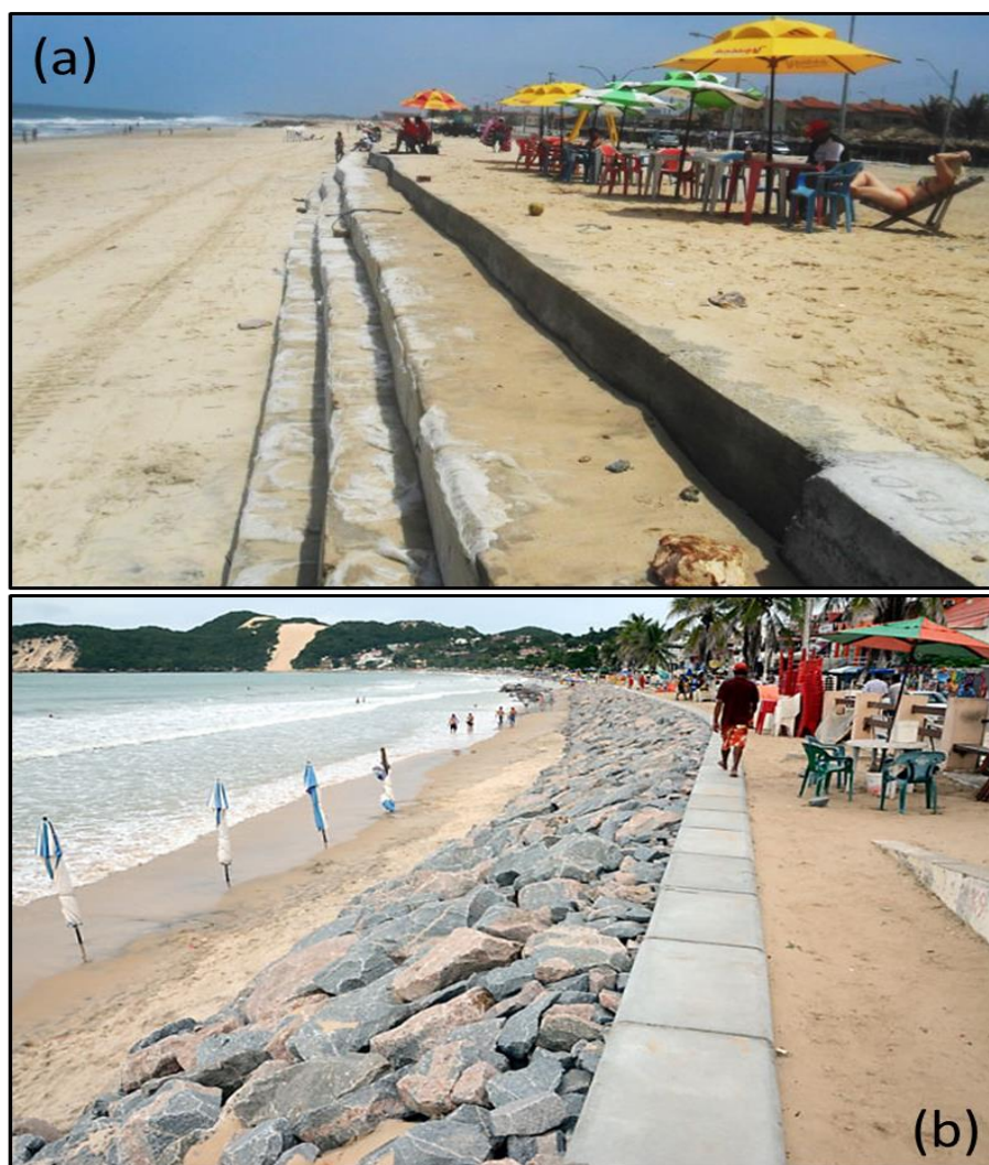
Figura 26 - Obras de contenção a erosão costeira implantadas nas praias de interesse desse estudo. (a) Bagwall – Praia do Icaraí; (b) Enrocamento aderente – Praia de Ponta Negra.
