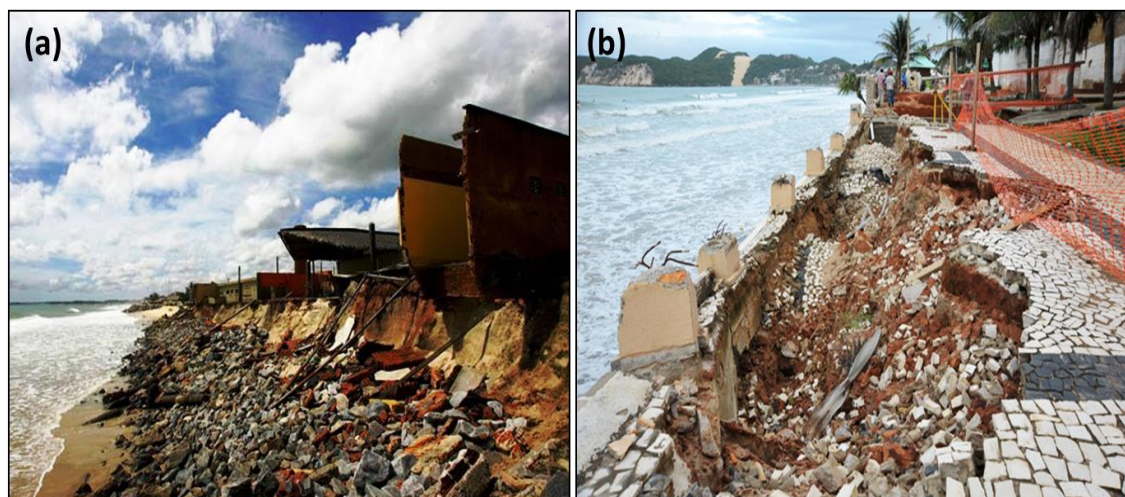
Figura 24 – Impactos da erosão costeira nas praias do Icaraí e Ponta Negra. (a) Ruínas das barracas da praia do Icaraí; (b) Destroços do calçadão da praia de Ponta Negra.
