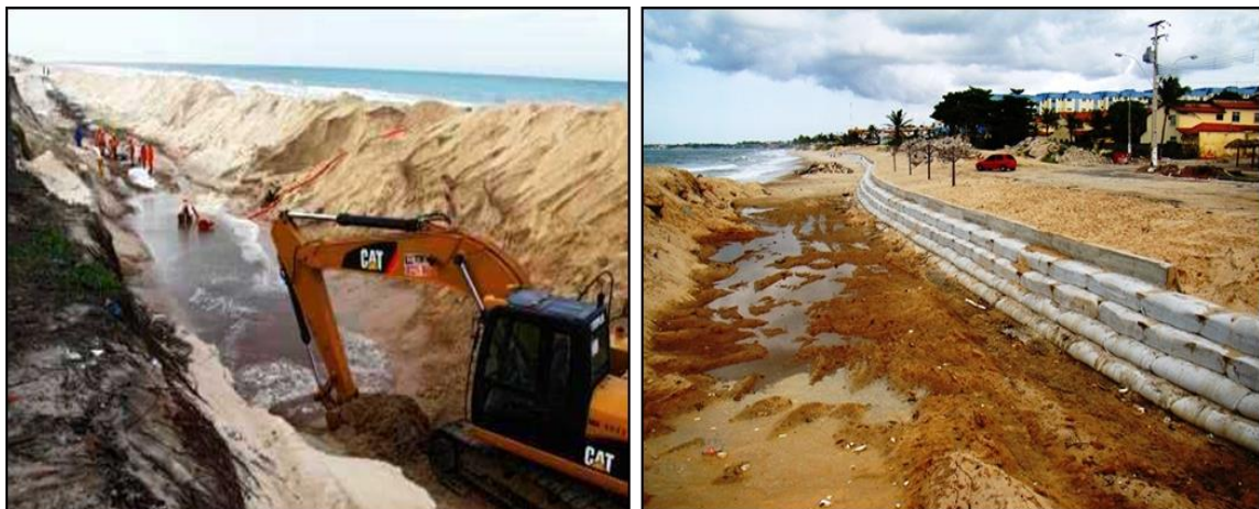
Figura 14 - Escavações e construção do Bagwall .
