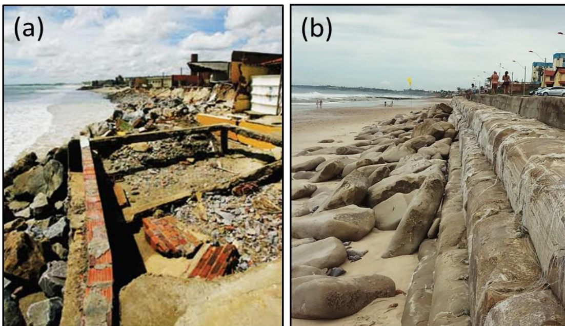
Figura 28 - Entulhos de obras na Praia do Icaraí. (a) Ruínas das barracas de praia em 2009; (b) Ruínas do Bagwall em 2016.
