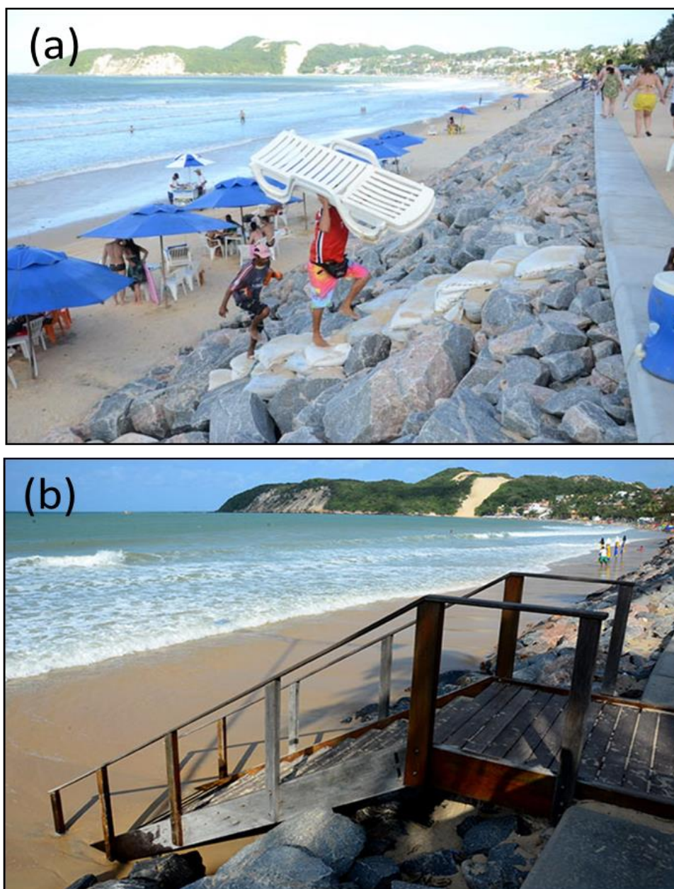
Figura 23 – Acessibilidade do enrocamento da praia de Ponta Negra. (a) Acesso improvisado pelos utilizadores; (b) Escadarias pertencentes ao projeto da obra.
