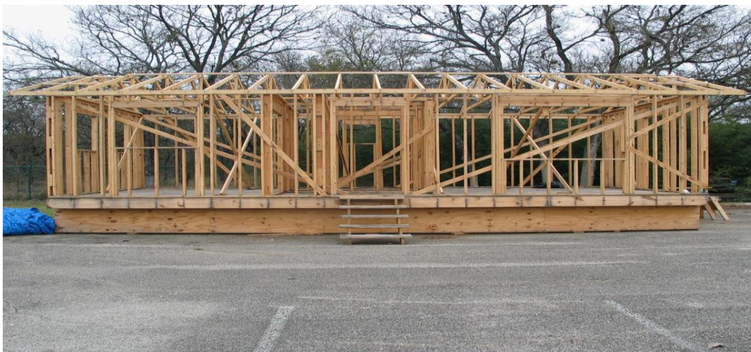
Figura 2.5 - Sistema construtivo wood frame .
