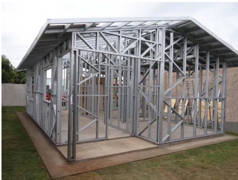
Figura 2.7 - Sistema construtivo steel frame para casa popular.
