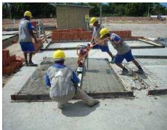
Figura 2.9 - Sistema construtivo em painéis de alvenaria e concreto armado.
