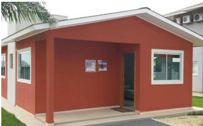
Figura 2.8 - Casa pronta no sistema construtivo steel frame .
