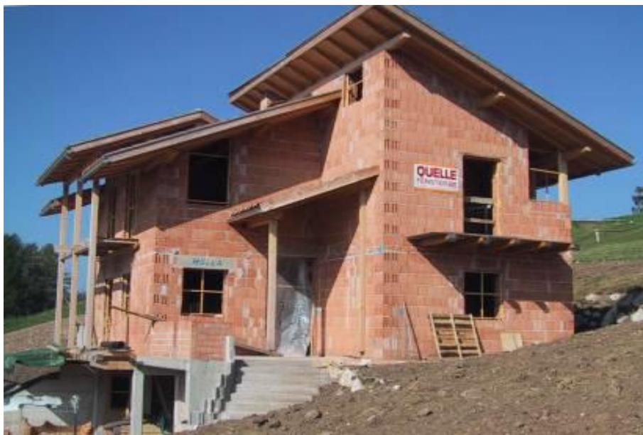
Figura 2.1 - Obra em alvenaria simples em Algarve, Portugal.
