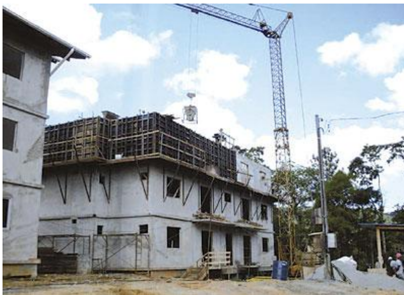
Figura 2.2 - Sistema construtivo com paredes de concreto.
