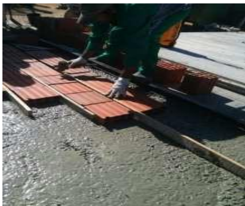
Figura 2.9 - Sistema construtivo em painéis de alvenaria e concreto armado.
