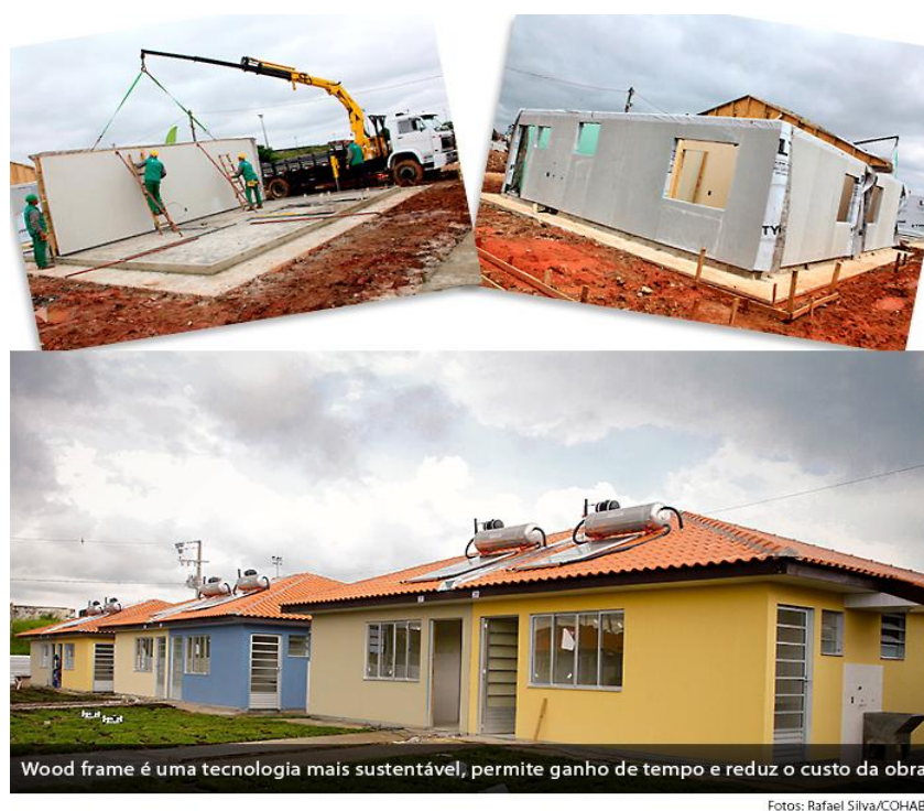
Figura 2.6 - Condomínio do MCMV em Curitiba.
