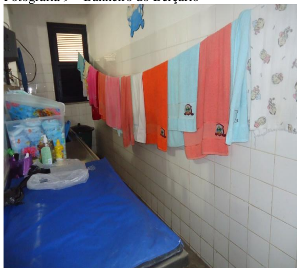
Fotografia 9 – Banheiro do Berçário
