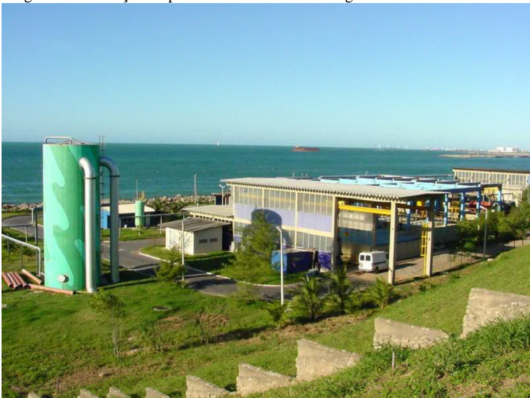
Figura 11 – Estação de pré-condicionamento de esgoto de Fortaleza
