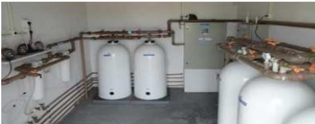
Figura 8 – Sistema de Tratamento da ETE Guadalajara - Filtros de Carvão Ativado
