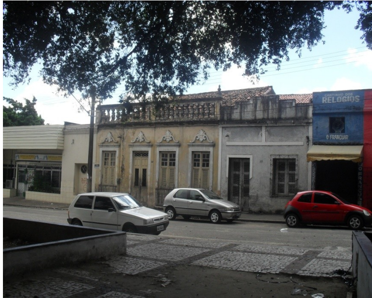
Figura Antigo conjunto arquitetônico
