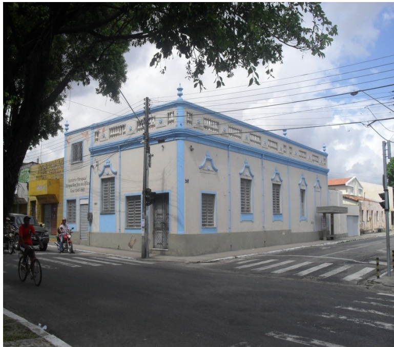
Figura Prédio da Câmara da Villa de Arronches
