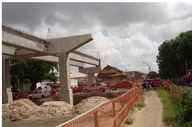
Figura 5 Construção do viaduto atingiria a estação. Foto de 2007. Fonte: Flickr
