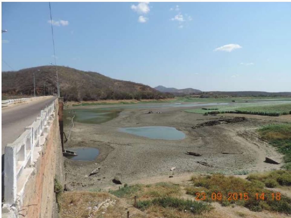
Figura 33: Vista da parede do açude Quixeramobim
