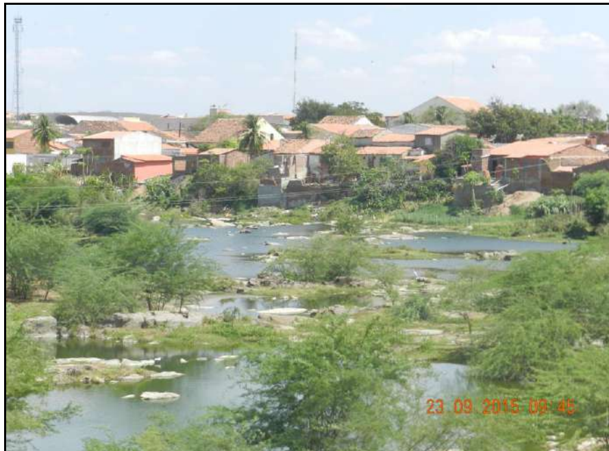
Figura 44: Planície fluvial do rio Quixeramobim. Observar a ocupação de risco nas margens
