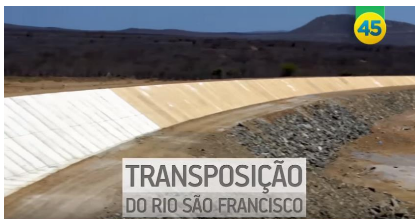
Figura 6 – Imagem das obras da transposição do Rio São Francisco, que foi exibida no HGPE dos dias 21, 22 e 23 de outubro de 2014.
