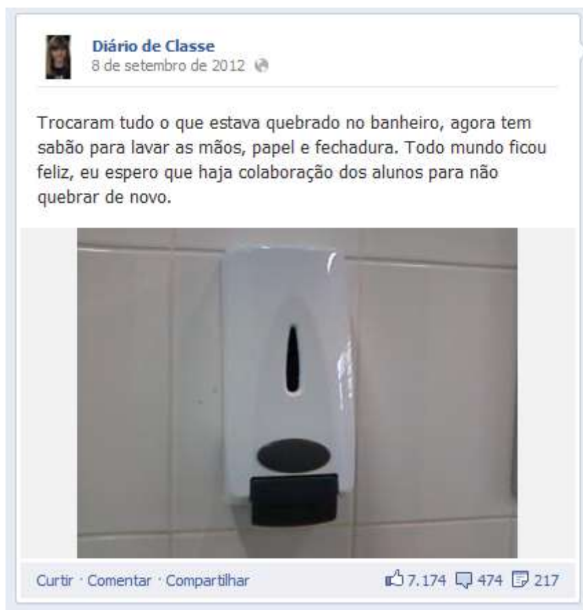
Figura 10: Fotos de melhorias da estrutura da escola.
