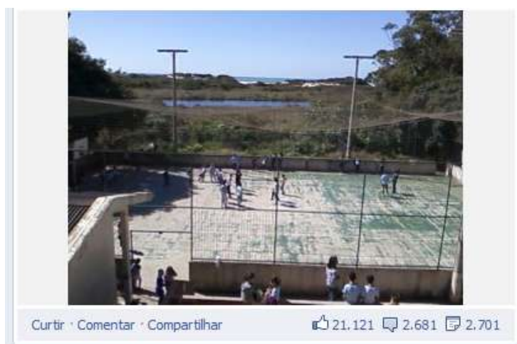
Figura 9: Reclamação acerca da falta de pintura da quadra escolar.
