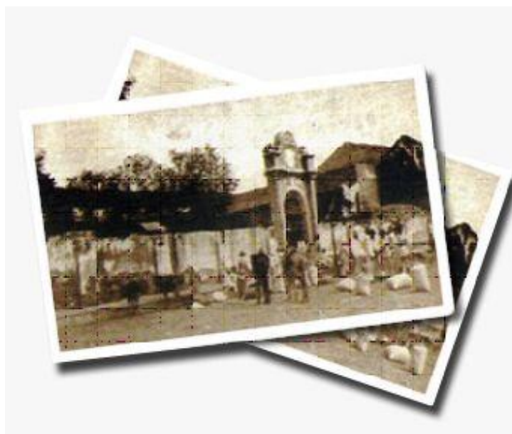
Figura 2 – Fachada da sede da “Cozinha do Povo”.
