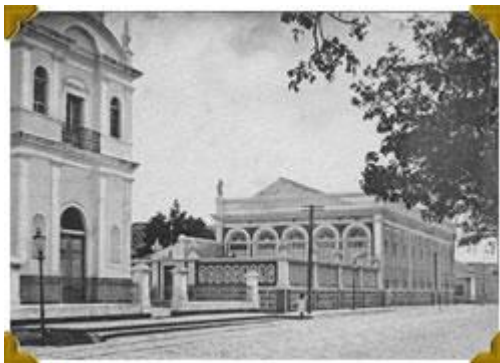
Imagem 3 – Prédio da Sociedade Fênix Caixeiral em 1919
