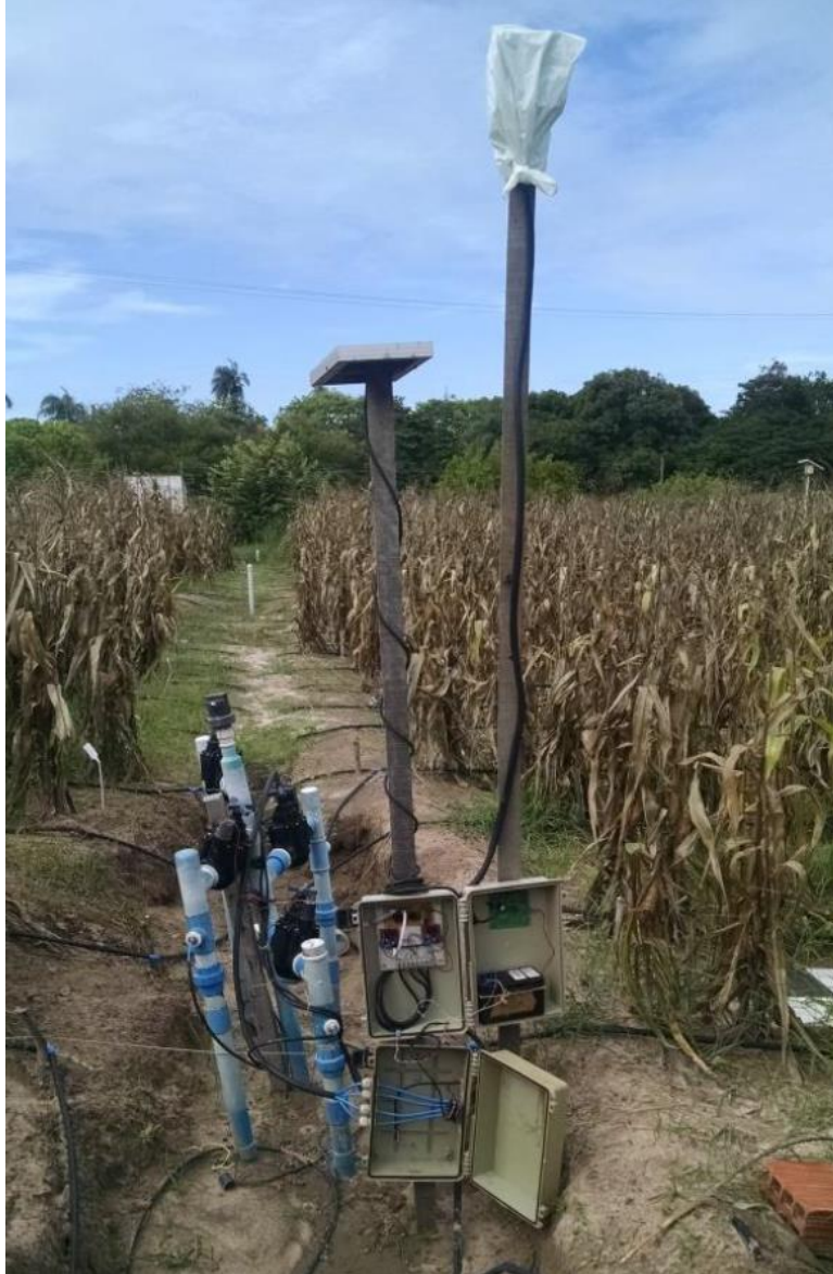
Figura 18: Módulo cavalete de válvulas instalado em campo
