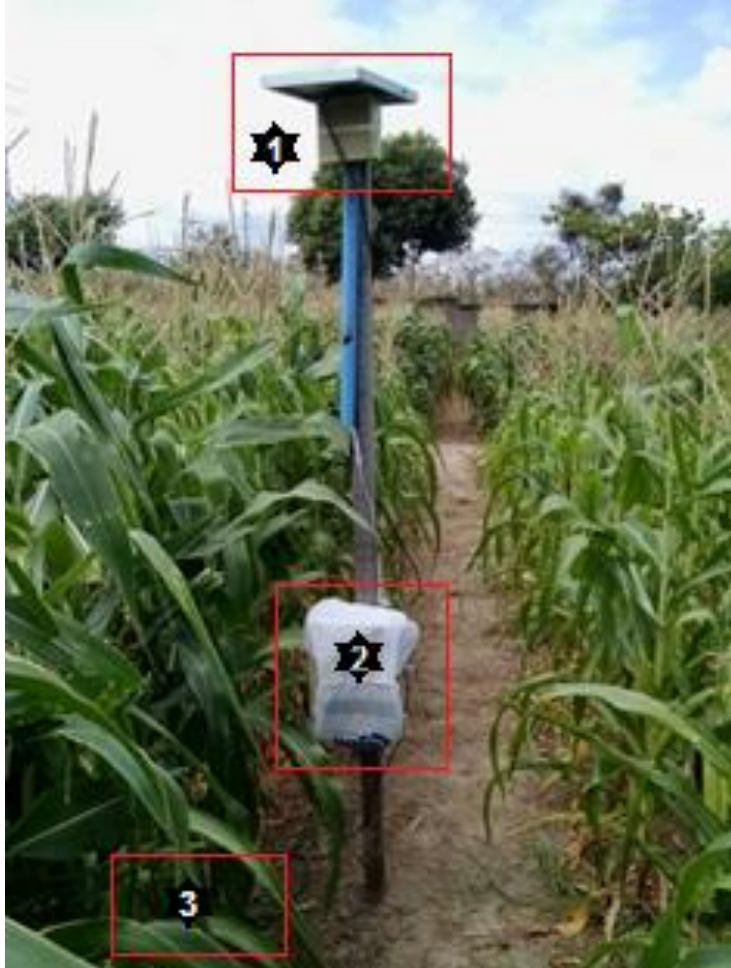
Figura 21: Módulo sensor instalado em campo: (1) Painel fotovoltaico e Transceptor; (2) caixa contendo placa de controle e monitoramento, placa multiplexadora, controlador de carga para carregar bateria com energia proveniente do painel fotovoltaico e bateria; e, (3) Sensores de umidade do solo instalado junto as raízes da cultura
