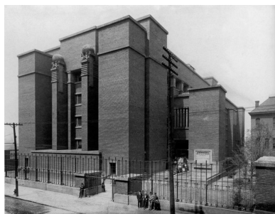
Figura 1.1. - Edifício Larkin, Frank Lloyd Wright (1903-05) Fonte: https://pt.wikiarquitectura.com/index.php/Edif%C3%ADcio_Larkin
