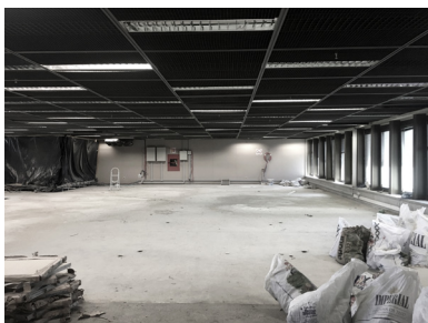
Figura 2.31. – Pavimento tipo em reforma Fonte: Acervo do autor.
