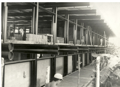
Figura 2.5. – Foto da obra do Palácio: estrutura tubular Fonte: Arquivo José Alberto Cabral.
