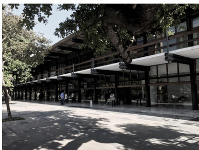
Figura 2.8. – Situação atual do Palácio: manutenção dos elementos externos Fonte: Acervo do autor.
