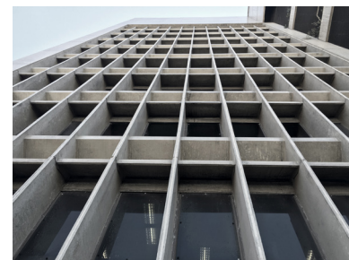
Figura 2.28. – Brises das fachadas norte e sul da torre Fonte: Acervo do autor.
