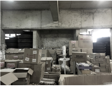
Figura 2.38 – Subsolo da SEDUC, atualmente funcionando como almoxarifado Fonte: Acervo do autor.
