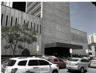
Figura 2.23. – Acesso principal ao pavimento térreo do edifício Fonte: Acervo do autor.
