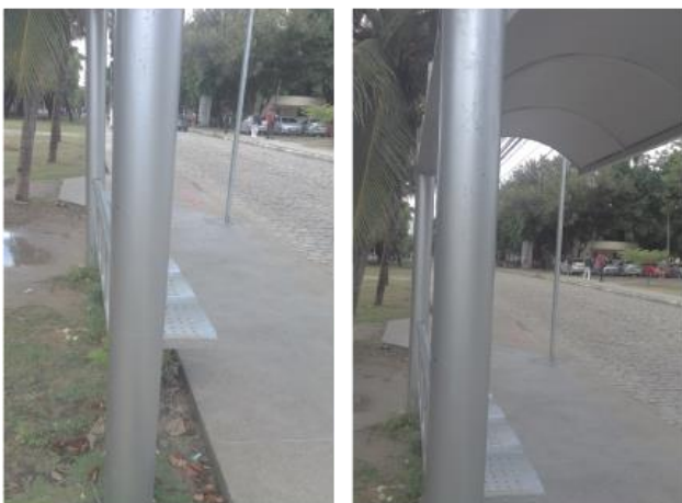
Figura 57 – Aparência da parada de ônibus do Centro de Tecnologia
