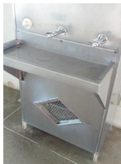
Figura 42 – Exemplo de um dos bebedouros localizados próximo à cantina da Jô
