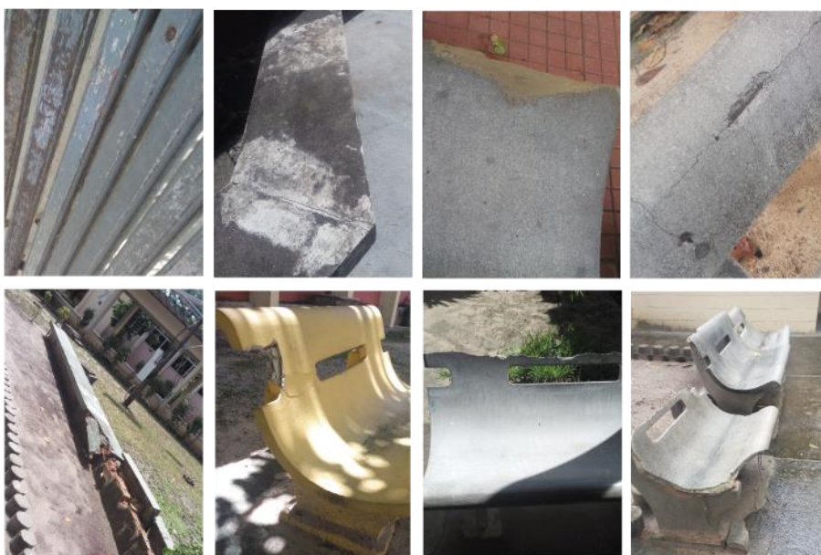
Figura 33 – Exemplos de bancos degradados nos espaços públicos do Centro de Tecnologia
