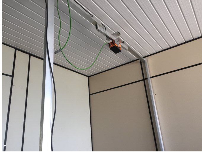
Figura 41 – Montagem do sensor de imagens
