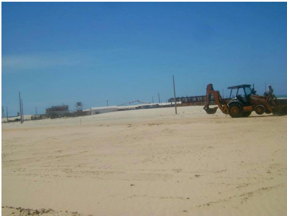
Figura 8: Terraplanagem de dunas frontais na praia do Japão.
