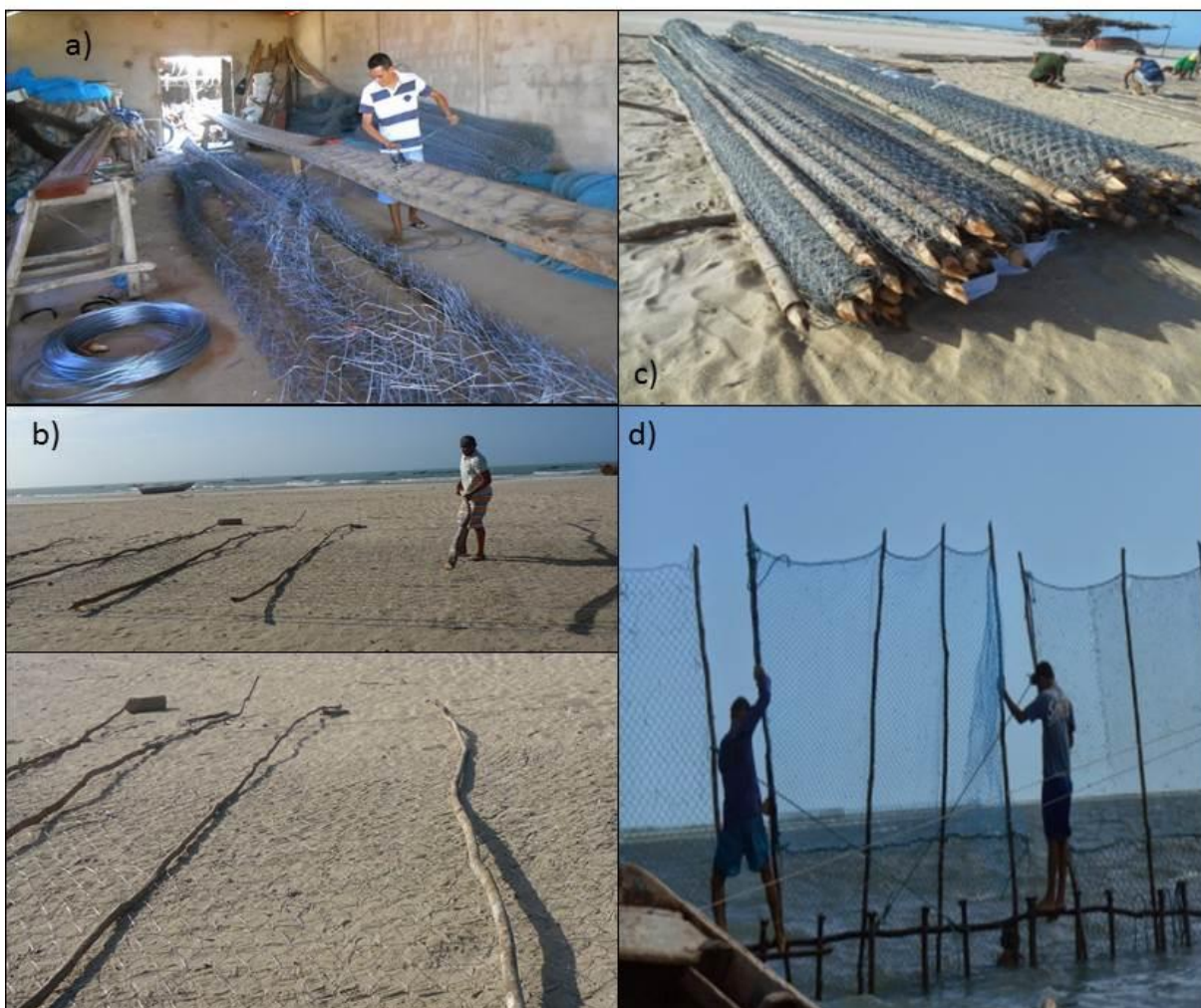
Figura 15 - Processos de confecção e montagem da esteira de um curral.
