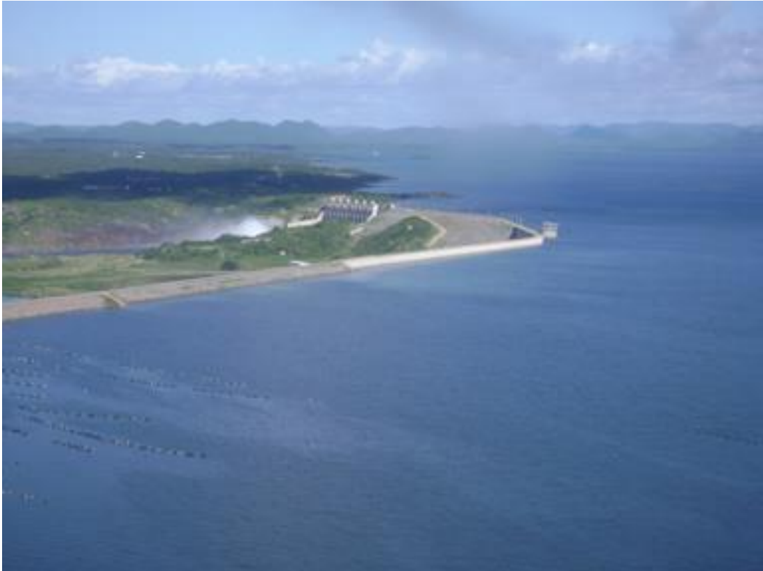
Figura 2.2 – Vista Aérea do Açude Castanhão no ano de 2004
