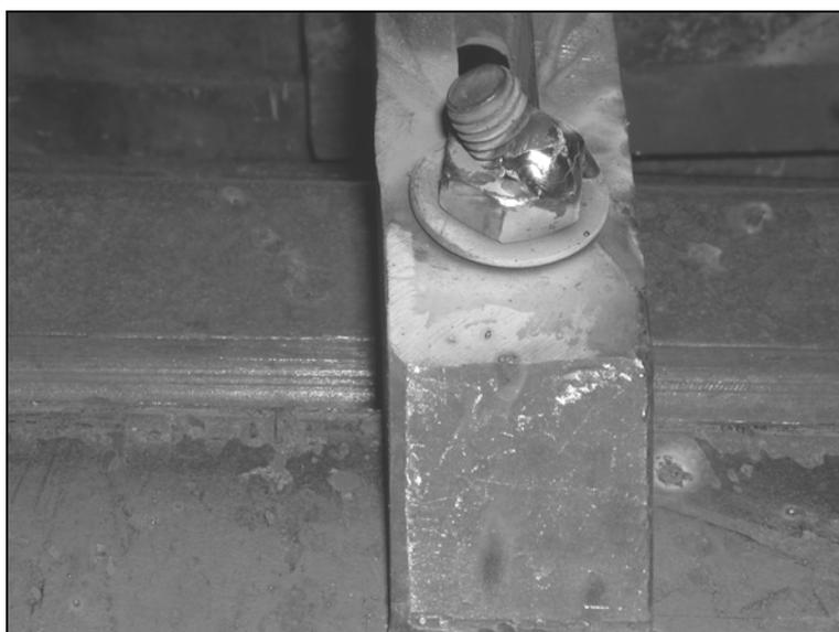
Figura 4.2 – Tensionamento excessivo da fixação devido às contrações térmicas
