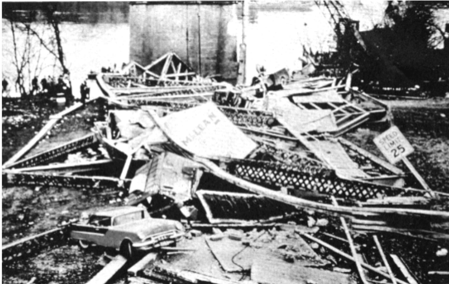
Figura 2.5 – Fotografia de Point Pleasant Bridge após o colapso
