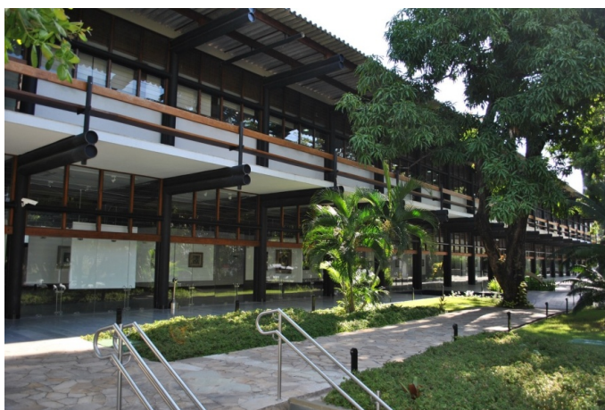
Figura 8 – Situação atual do Palácio: manutenção dos elementos externos
