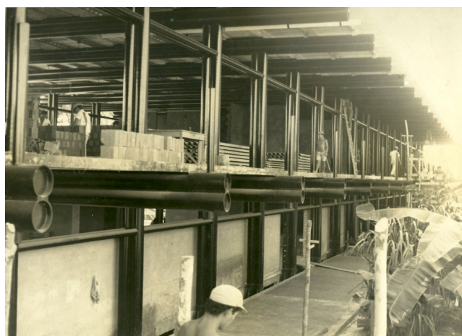
Figura 5 – Foto da obra do Palácio: estrutura tubular
