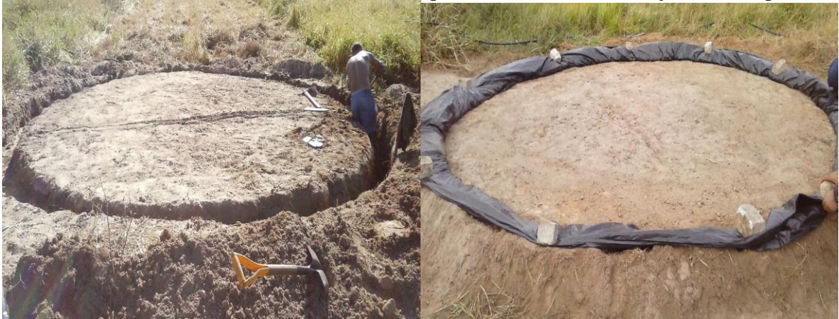
Figura 3 – Preparo do perfil e construção do dique de terra com a colocação da lona plástica.
