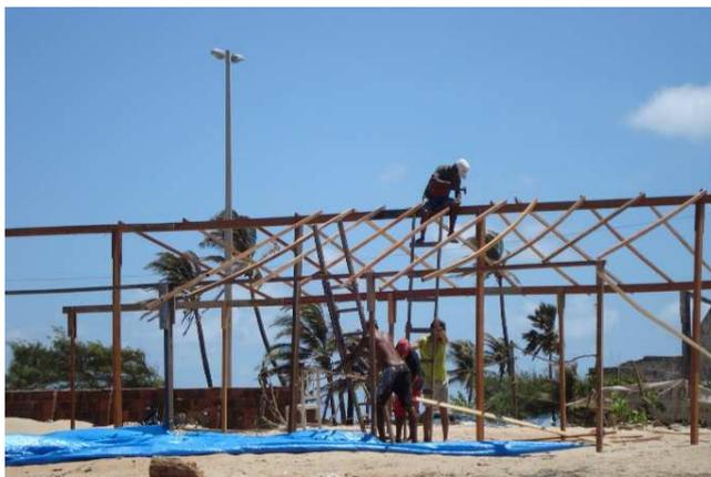
Figura 02. Mutirão para construção do “barracão” utilizando madeira e lona plástica.
