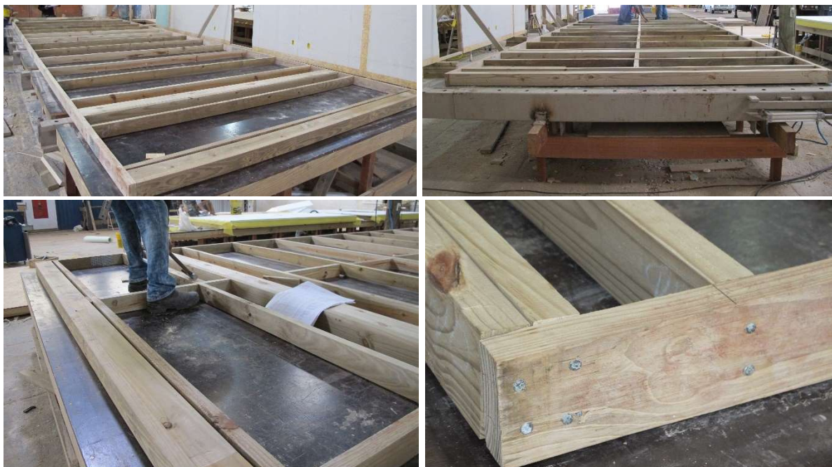
Figura 44 – Junção das peças com pregos galvanizados
