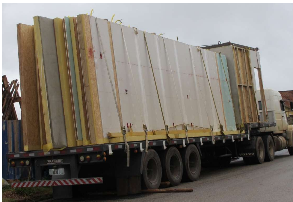
Figura 54 – Transporte dos painéis em caminhão
