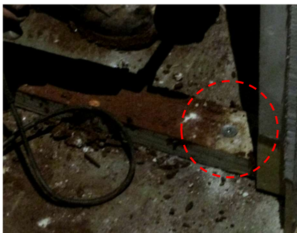
Fixação do painel no concreto do Radier (fundação)
