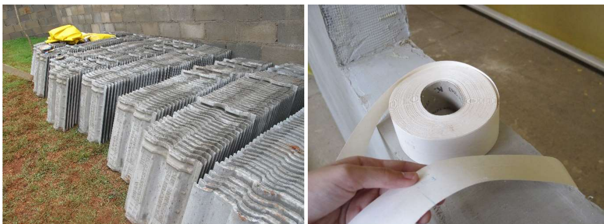
Figura 70 – Etapas finais: telhas e fita para tratamento de juntas das placas de gesso
