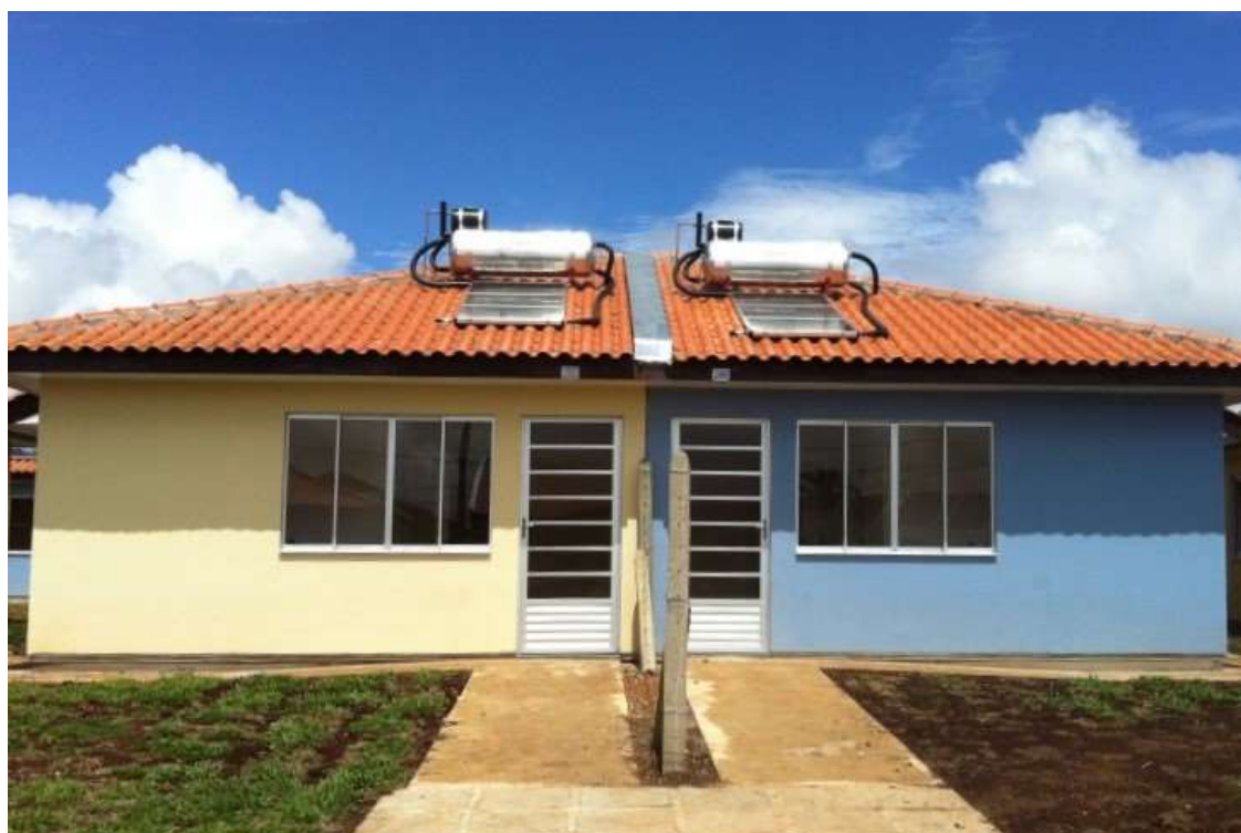
Figura 85 – Casas, construídas com o sistema wood frame , em uso na cidade de Curitiba
