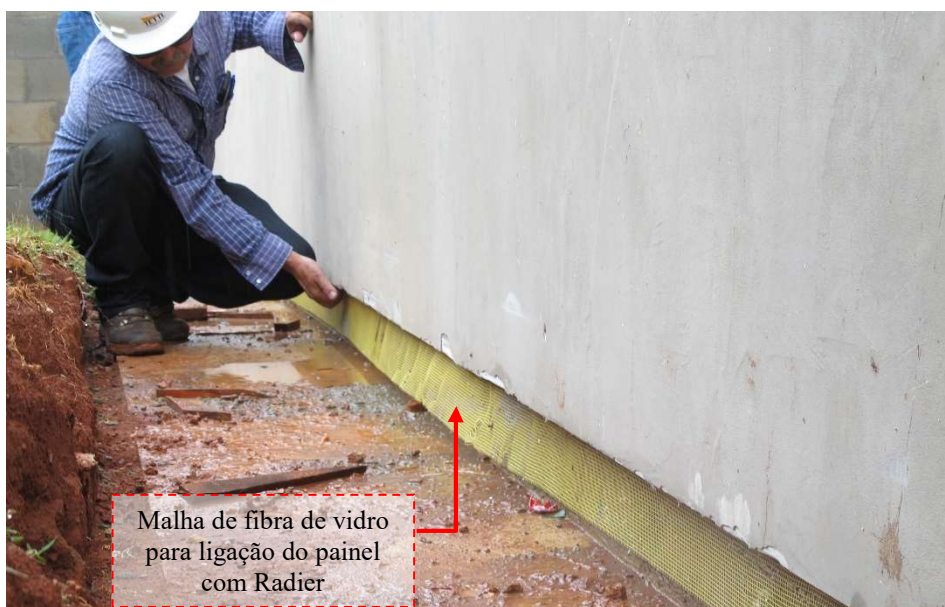
Figura 62 – Ajuste da malha de fibra de vidro ao Radier (fundação)
