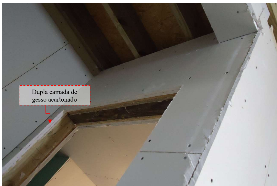
Figura 82 – Dupla camada de gesso acartonado no acabamento interno dos edifícios
