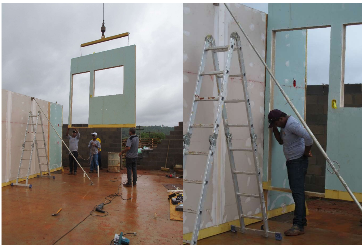
Figura 64 – Alocação de painel em wood frame no Radier (fundação)
