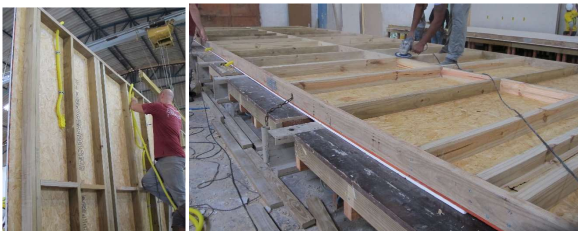
Figura 50 – Execução de segunda face com painel em pé ou deitado
