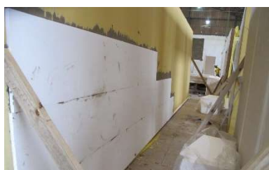
Figura 52 – Acabamento da face externa do painel de wood frame
