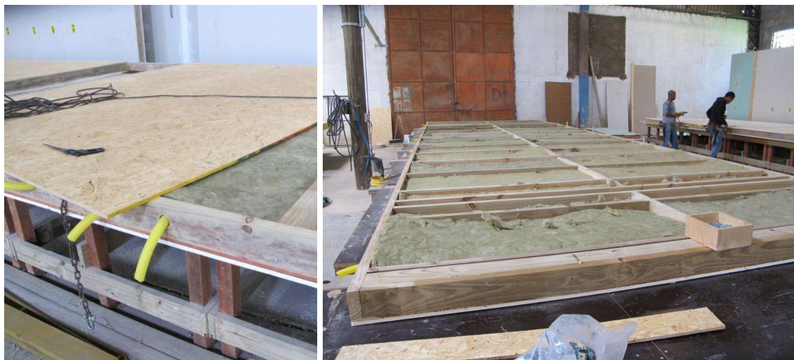
Figura 51 – Região interna finalizada de painéis em wood frame
