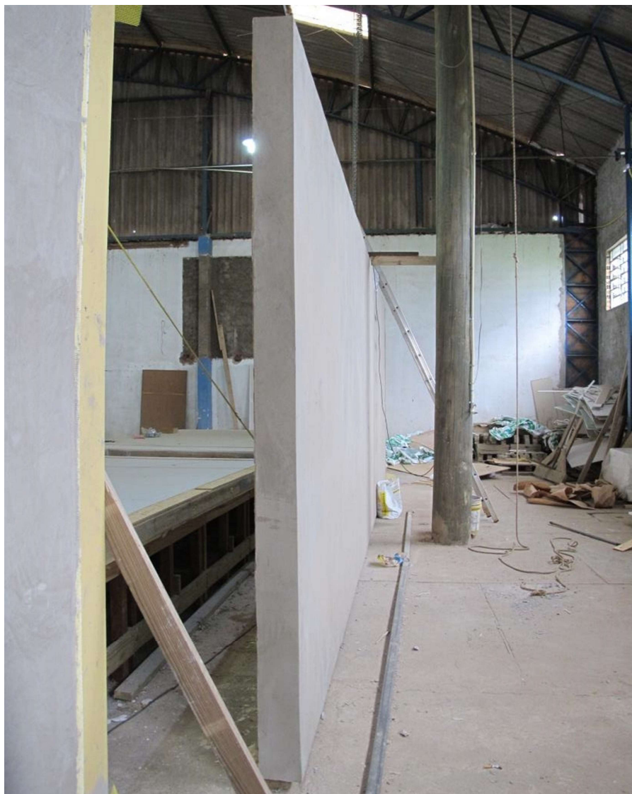
Figura 53 – Aspecto final do painel de wood frame com acabamento externo em EIFS
