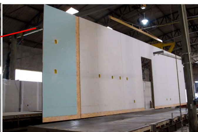
Pórtico rolante manual fixo (Centralizado com as mesas de montagem)
