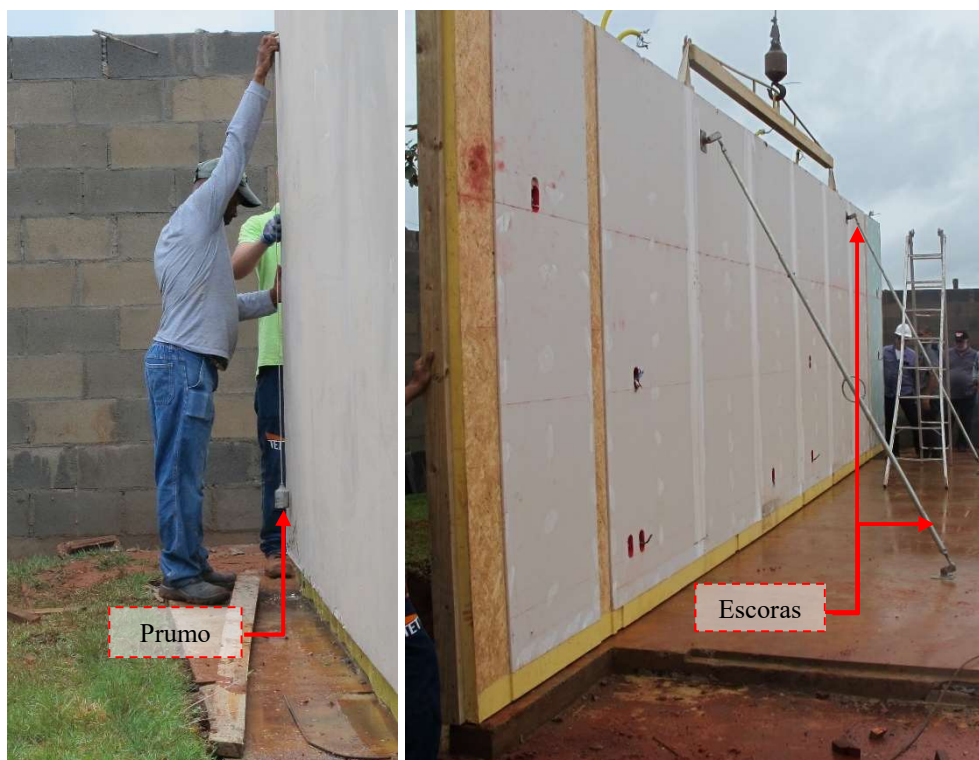
Figura 61 – Ajuste do prumo do primeiro painel ao Radier (fundação)
