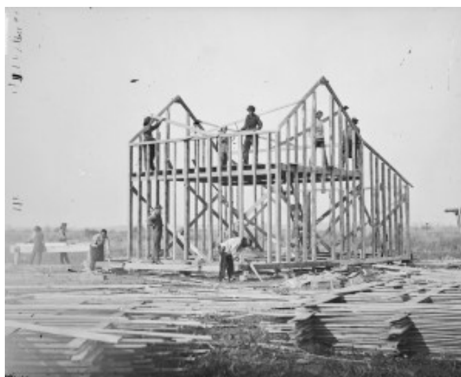
Figura 6 – Primeira obra no sistema balloon frame
