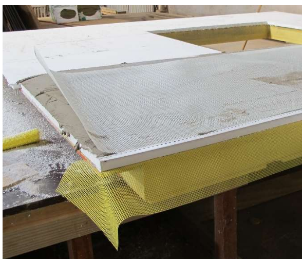
Região inferior do painel com proteção reforçada com armadura de malha de vidro
