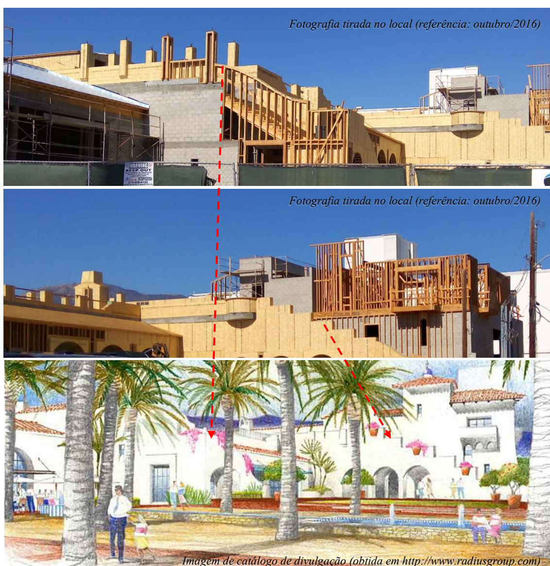
Figura 92 – Edificação mista em blocos de concreto e madeira em Santa Bárbara/CA
