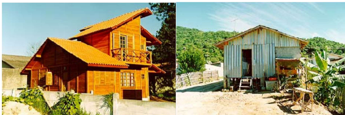
a) Sistema construtivo em madeira maciça empilhada
