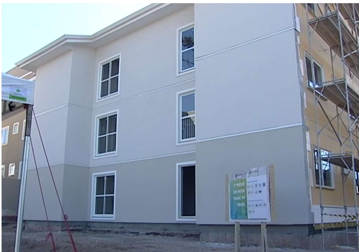
Figura 74 – Primeiro bloco do edifício em wood frame
