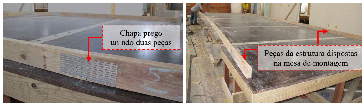
Figura 43 – Disposição das peças da estrutura na mesa de montagem
