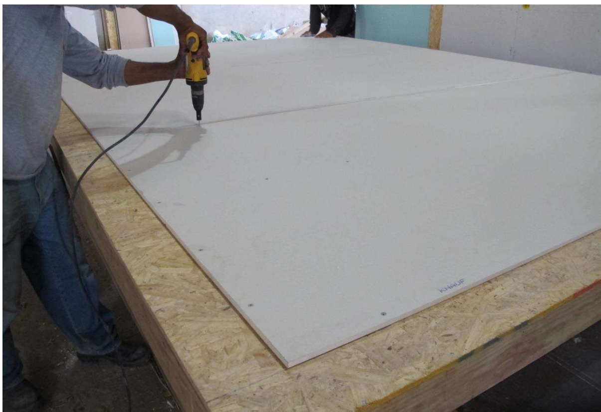
Figura 48 – Fixação de placas de gesso no painel
