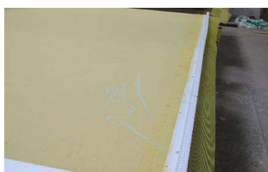
Figura 52 – Acabamento da face externa do painel de wood frame
