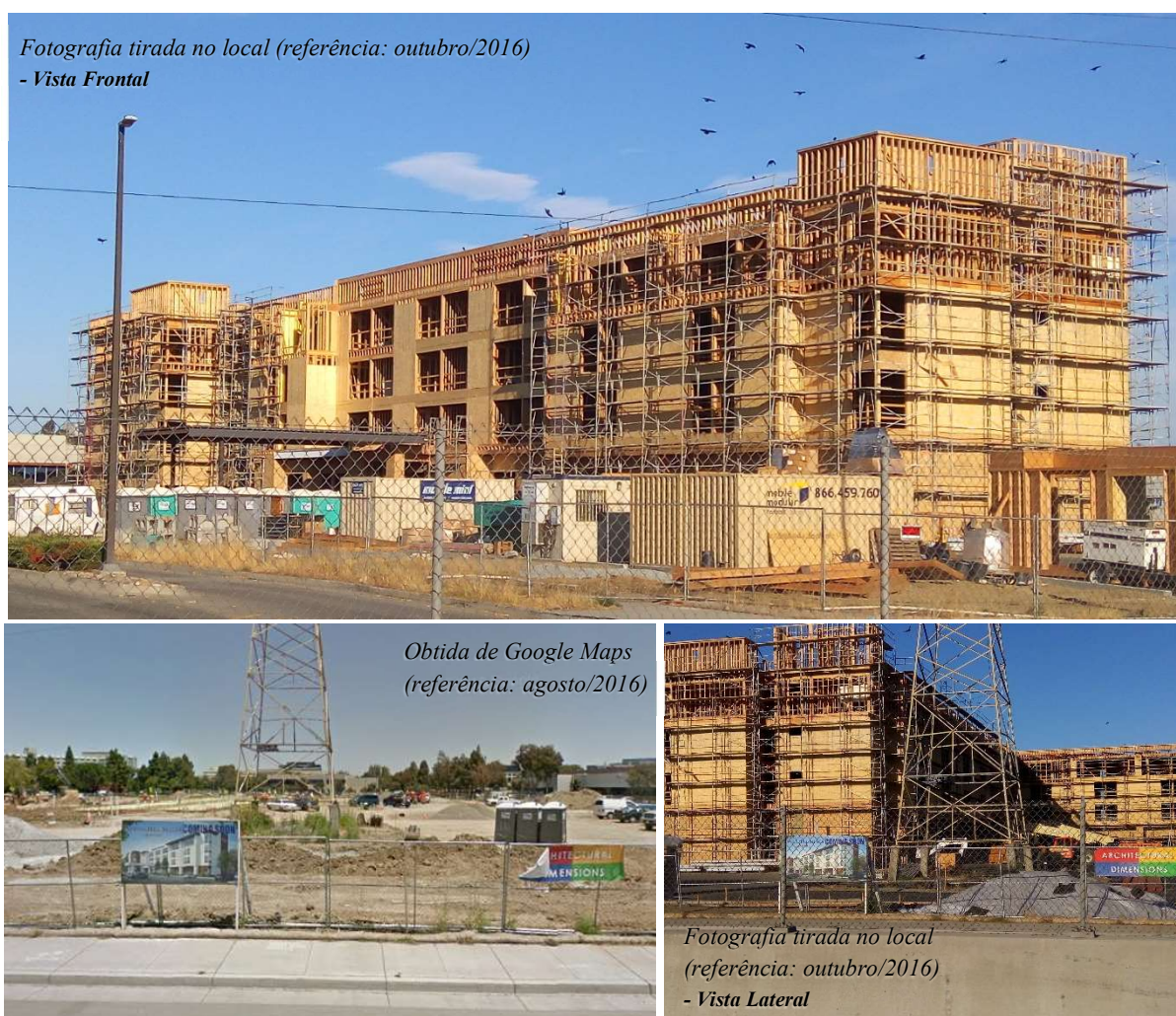
Figura 94 – Prédio em wood frame nos Estados Unidos
