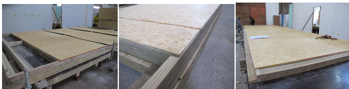
Figura 47 – Placas de OSB na estrutura em esquadro
