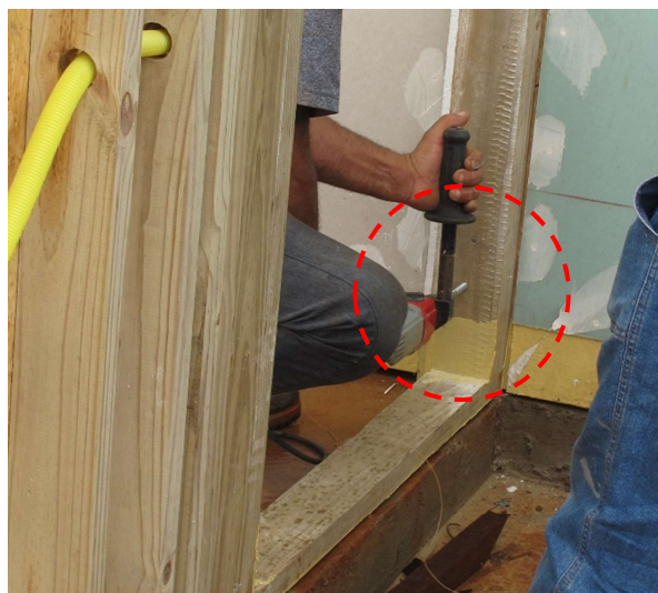
Fixação entre painéis simples
