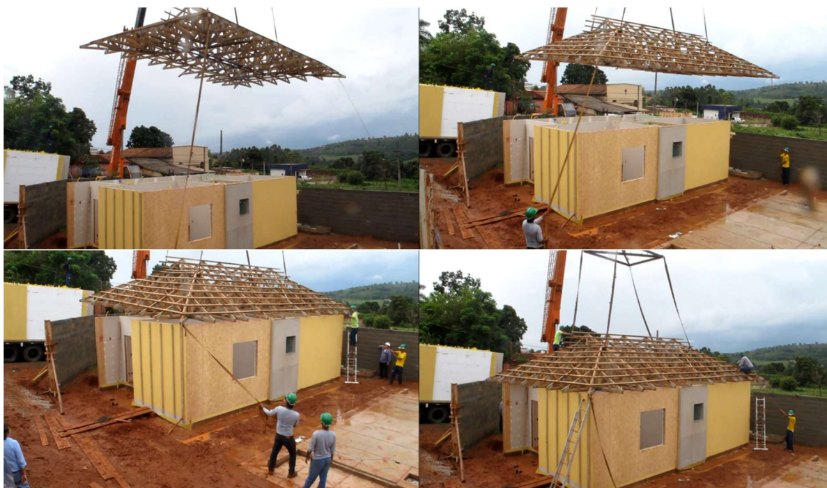
Figura 68 – Montagem da cobertura da edificação em wood frame
