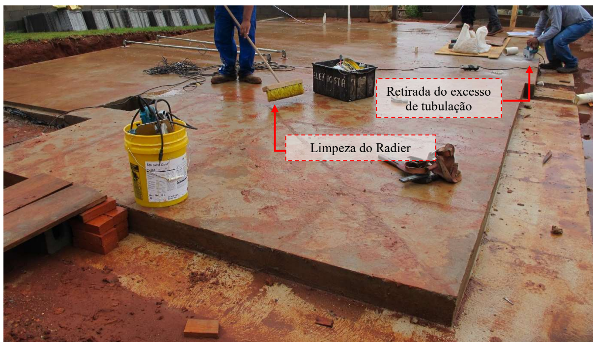
Figura 60 – Limpeza do Radier para receber os painéis
