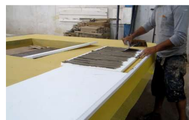
Figura 52 – Acabamento da face externa do painel de wood frame
