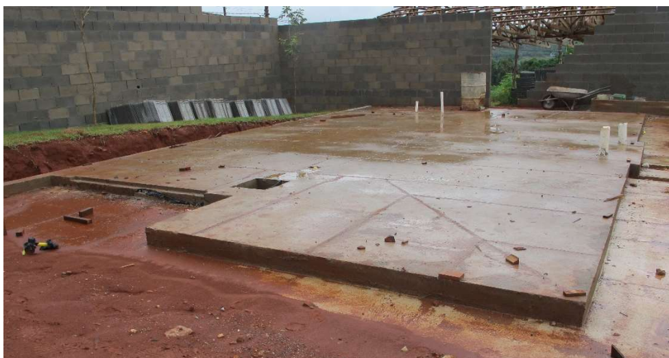
Figura 58 – Fundação de casa em wood frame
