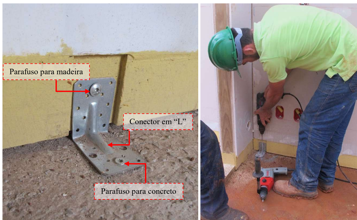
Figura 69 – Ancoragem da edificação em wood frame
