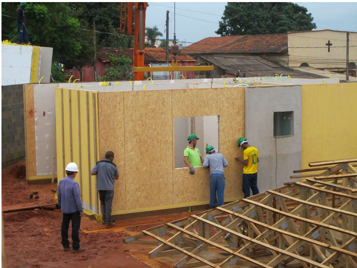
Figura 67 – Último painel sendo alocado, dando forma à edificação em wood frame
