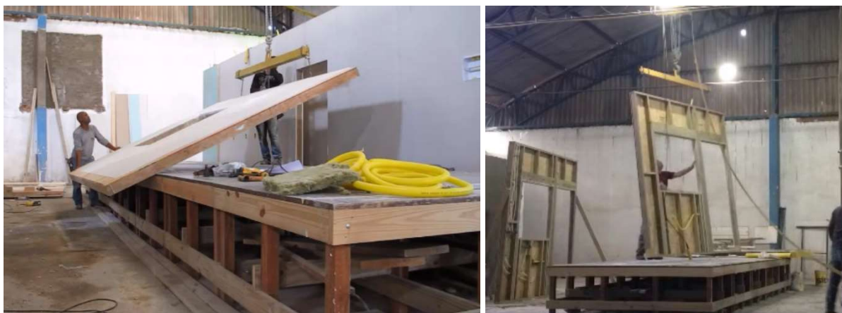
Figura 49 – Movimentação dos painéis em wood frame
