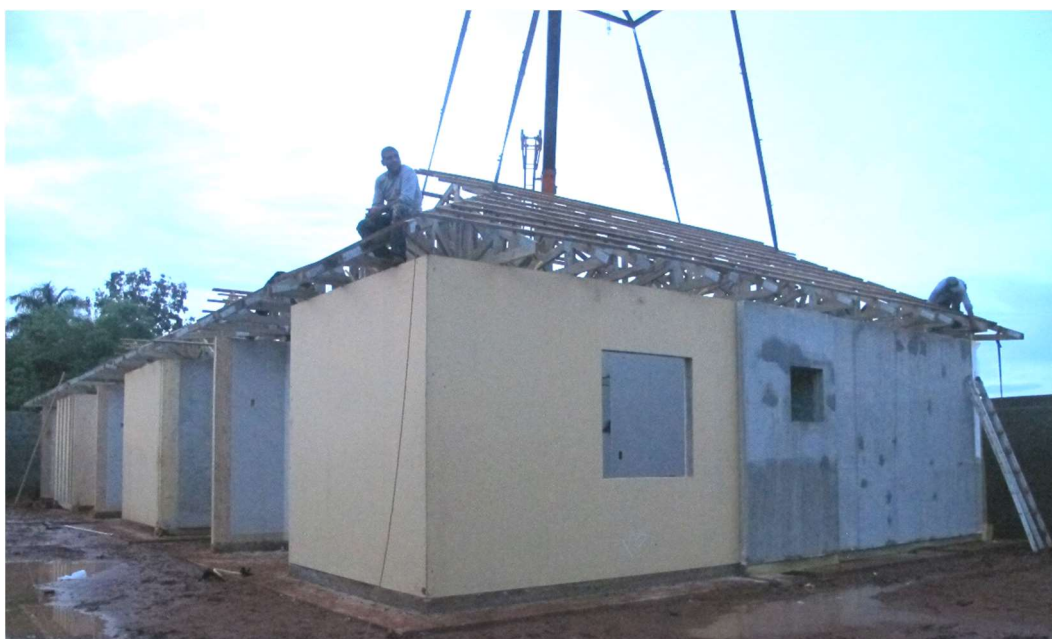
Figura 71 – Casas em wood frame com estrutura pronta
