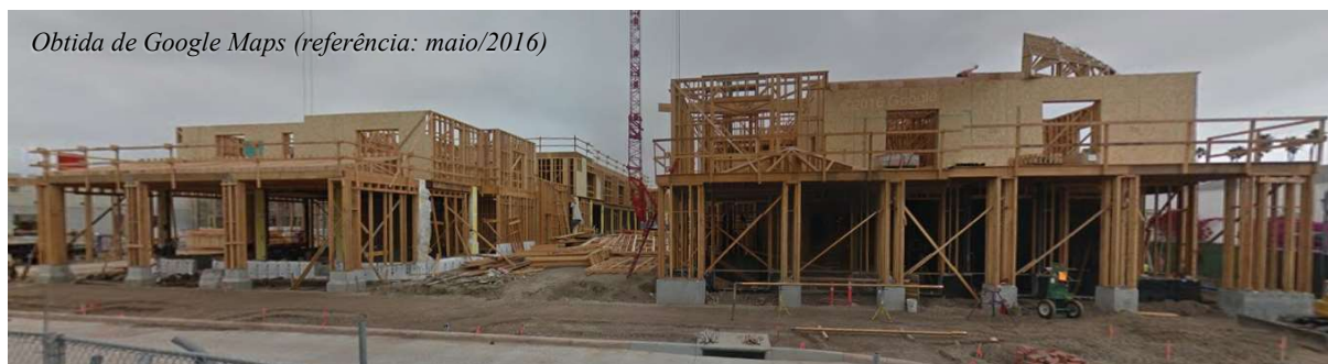
Figura 93 – Edificação em wood frame em Santa Bárbara/CA
