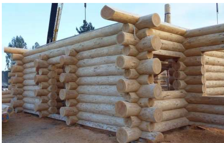
Figura 3 – Exemplo de estrutura de edificação em toras em construção
