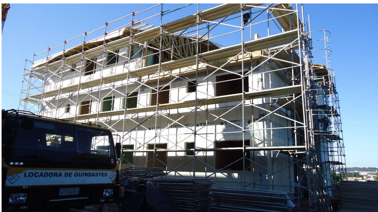
Figura 75 – Segundo bloco do edifício em wood frame
