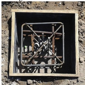
Figura 3.10: Vista dos blocos de coroamento com 1 estaca e 4 estacas
