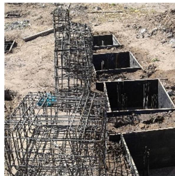
Figura 3.10: Vista dos blocos de coroamento com 1 estaca e 4 estacas
