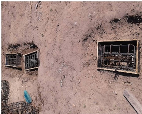
Figura 3.9: Vista dos blocos de coroamento de 2 estacas com suas armaduras
