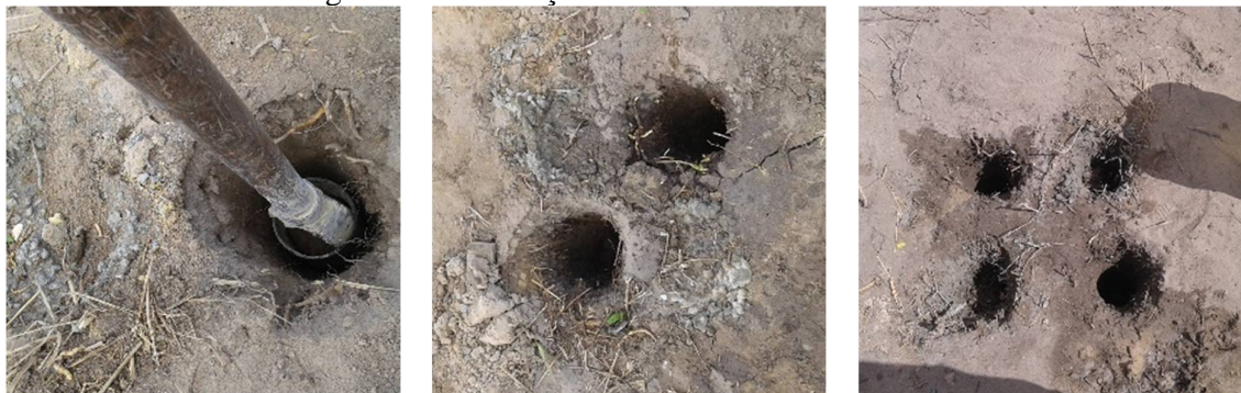
a) 1° estaca escavada, 1° dia. b) 2° estaca escavada, 1° dia. c) vista de todas as estacas escavadas.
