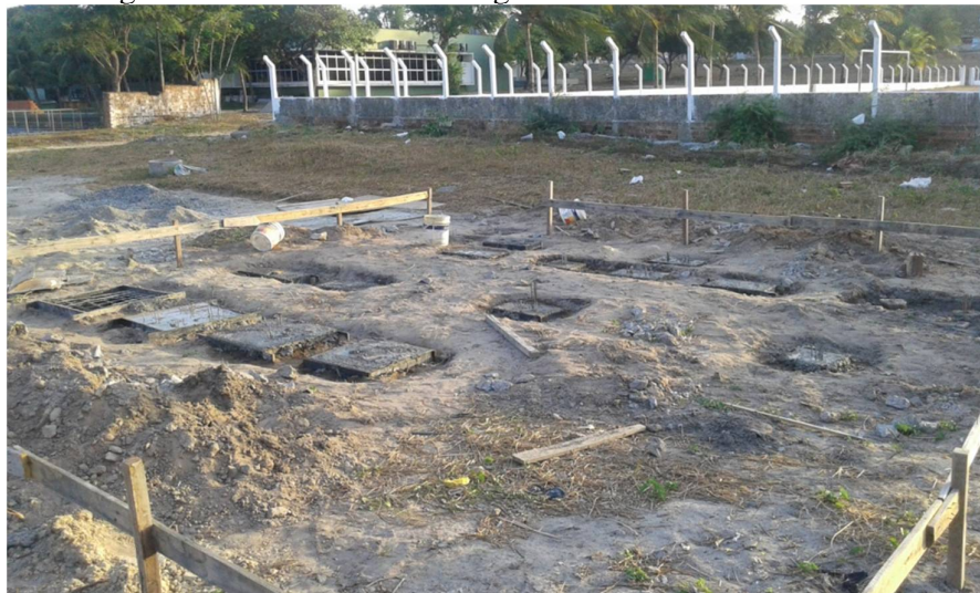
Figura 3.11: Vista da concretagem dos blocos de coroamento
