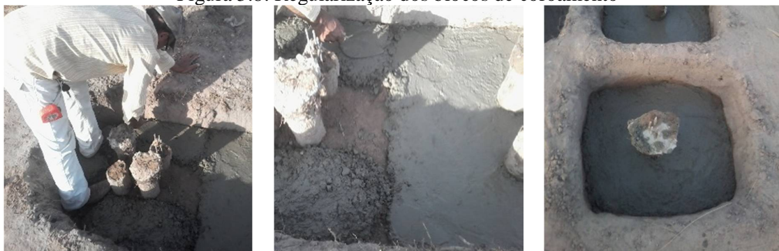
Figura 3.8: Regularização dos blocos de coroamento
