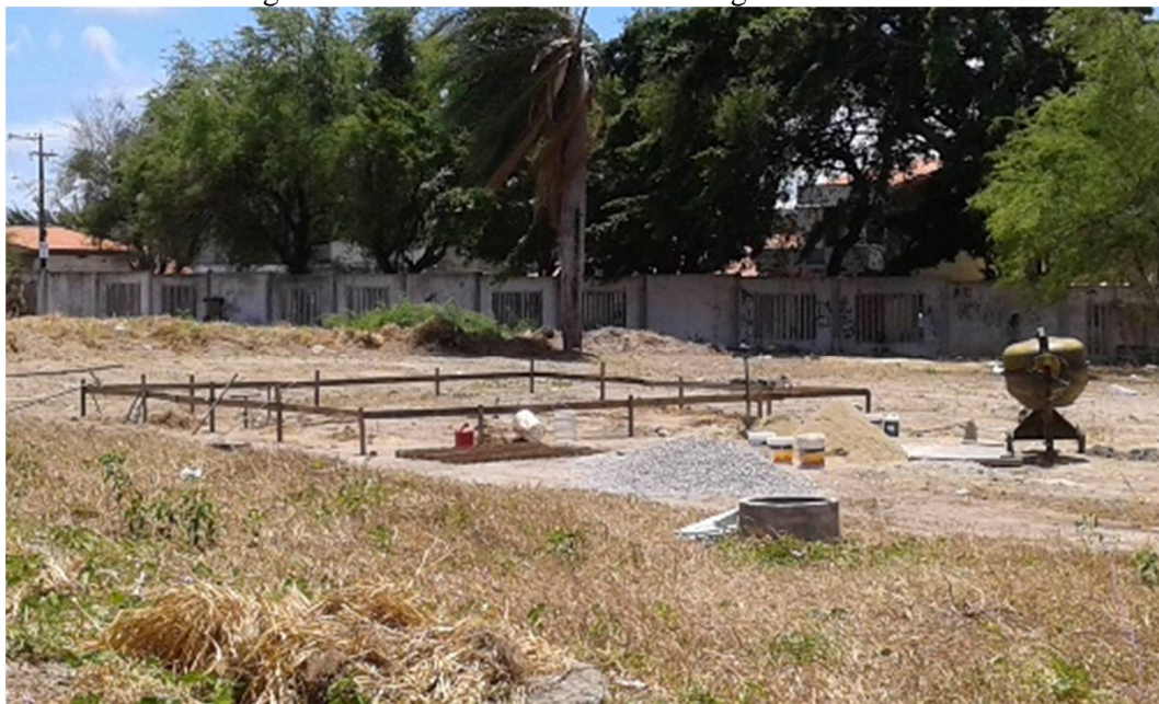
Figura 3.5: Vista do local na concretagem das estacas
