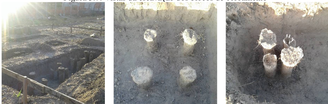
a) Vista geral da escavação dos blocos de coroamento. b) Escavação do bloco de 4 estacas com 4D de espaçamento. c) Escavação do bloco de 4 estacas com 2D de espaçamento.
