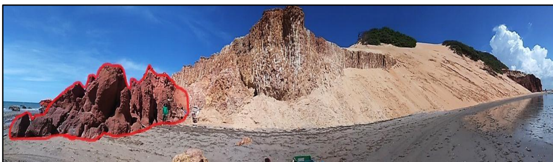
Figura 3.14 – Laterito na base da falésia.
