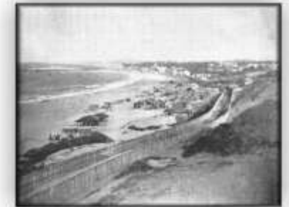
Fig. 59: Arraial Moura Brasil. Destaque para a longa murada que protegia a linha de ferro da ocupação irregular.
