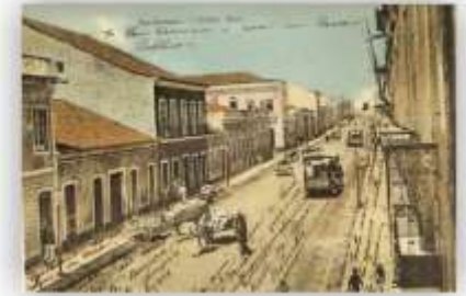
Fig. 68 (acima): Cartão-postal colorizado a mão da Rua Formosa (atual Avenida Barão do Rio Branco) em 1908 e fig. 69 (abaixo): Cartão postal do Mercado de Ferro, de 1899. Exemplos da representação de fragmentos de Fortaleza nos meios de correspondência. Fonte: Chaves et al, 2006, p. 84 e 158.
