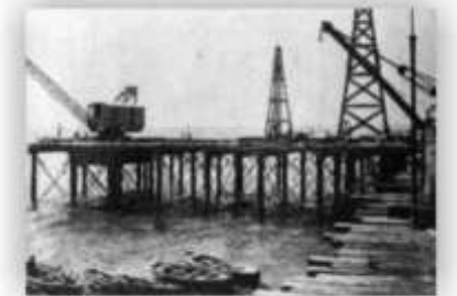
Fig. 85: Guindastes da Ponte Metálica. Fonte: Arquivo Nirez.
