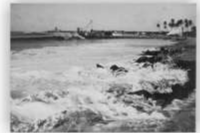
Fig. 118: Águas revoltas na praia do Meireles. Ao fundo, as obras do Porto do Mucuripe.
