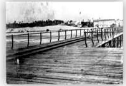
Fig. 83: Construção da Ponte Metálica. Fonte: Arquivo Nirez.
