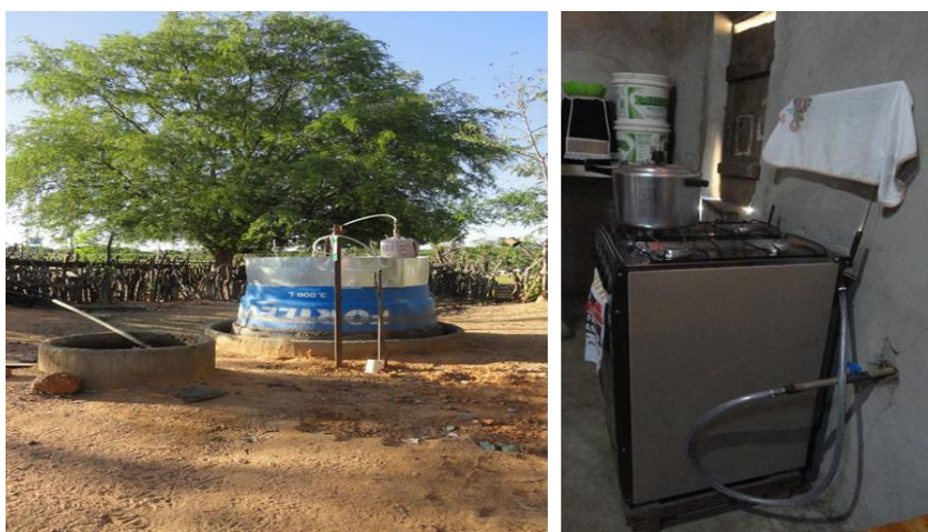
Figura 17 - Utilização de esterco bovino para produção de gás de cozinha e fertilizante natural em biodigestor
